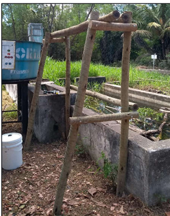
Figura 14 - Montagem da estrutura do sistema piloto
