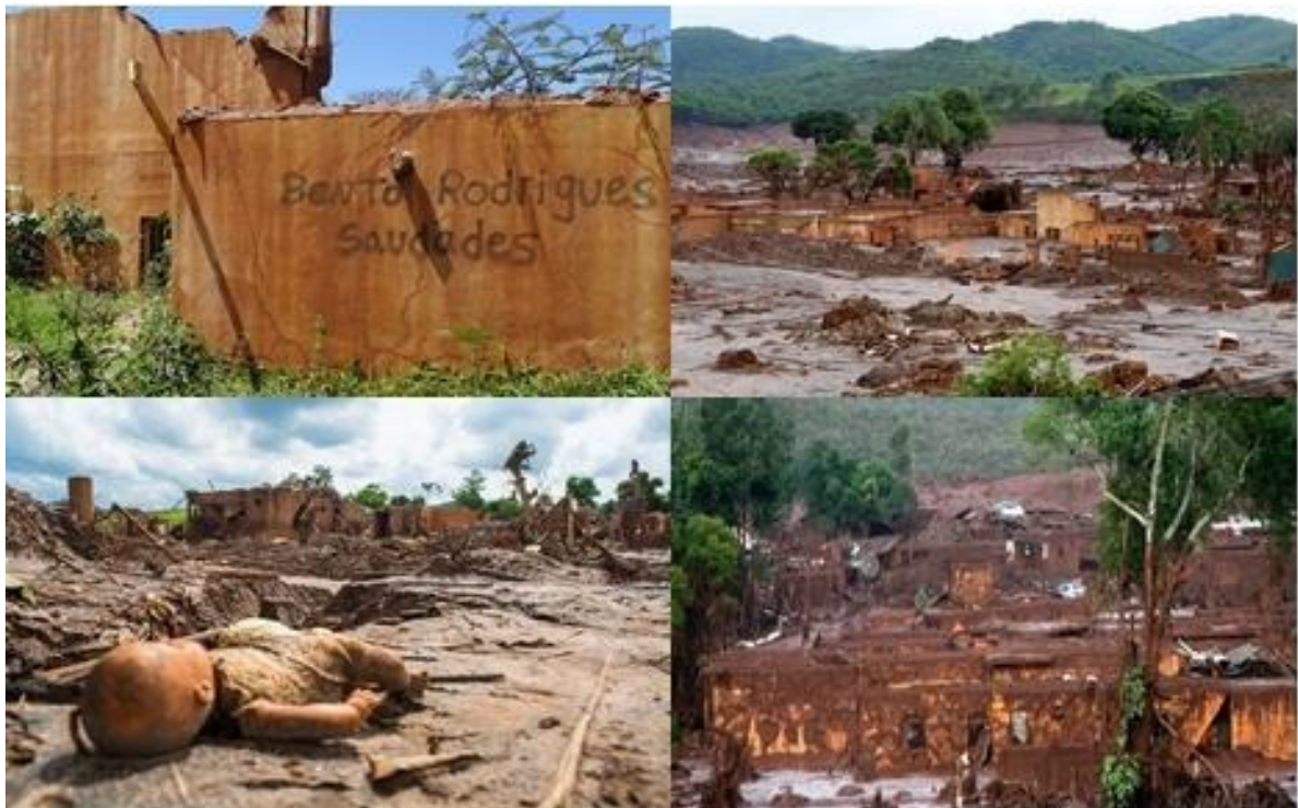
Figura 11 – Bento Rodrigues após o rompimento da barragem de Fundão
