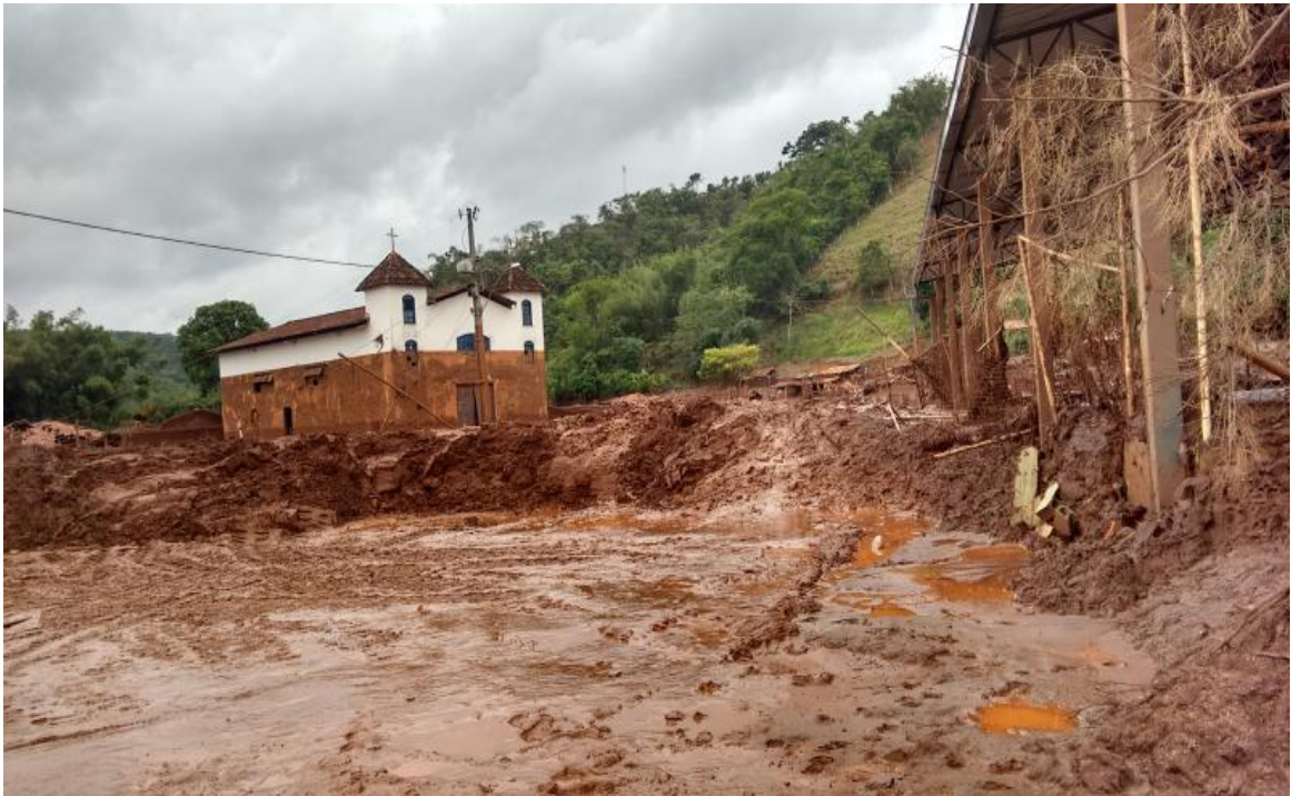
Figura 14 – Igreja de Santo Antônio após o rompimento da barragem de Fundão, em Paracatu de Baixo
