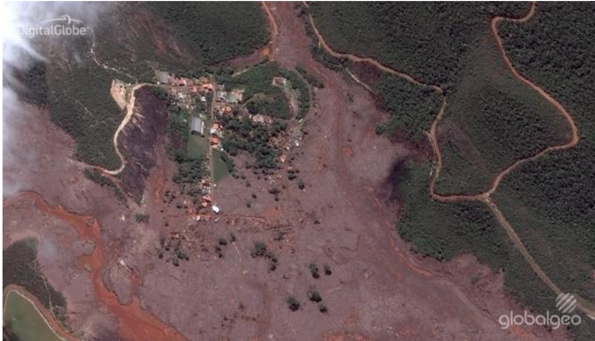
Figura 10 – Visão panorama do povoado de Bento Rodrigues após o rompimento da barragem
