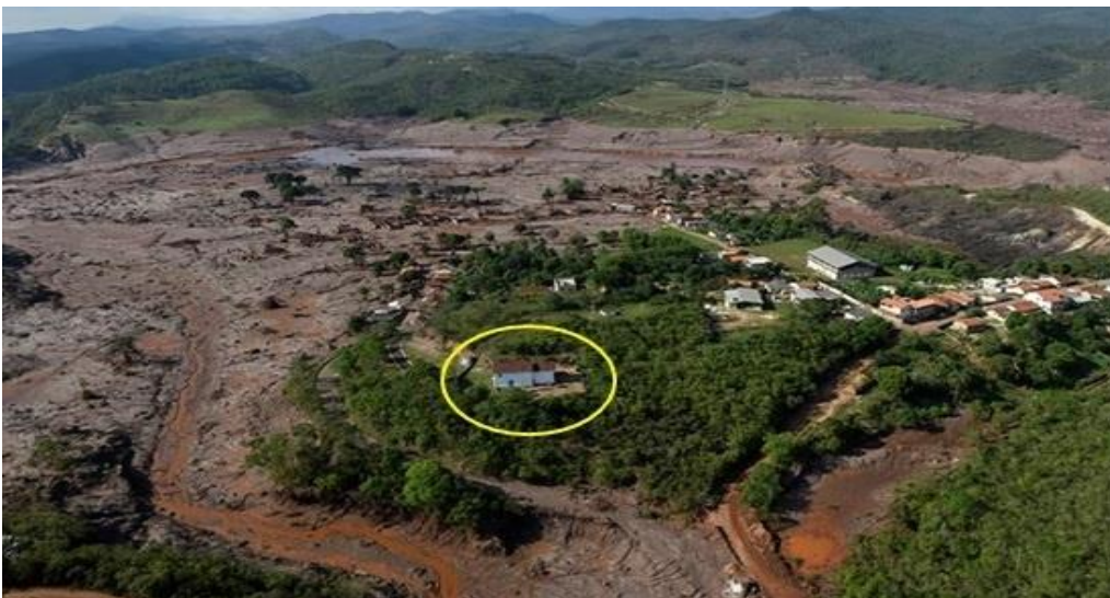
Figura 8 – Igreja de Nossa Senhora das Mercês após o rompimento da barragem
