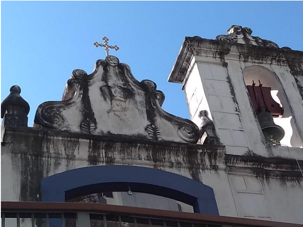
Figura 10 – Frontão e torre sineira da Capela de Santa Luzia. Vitória-ES
