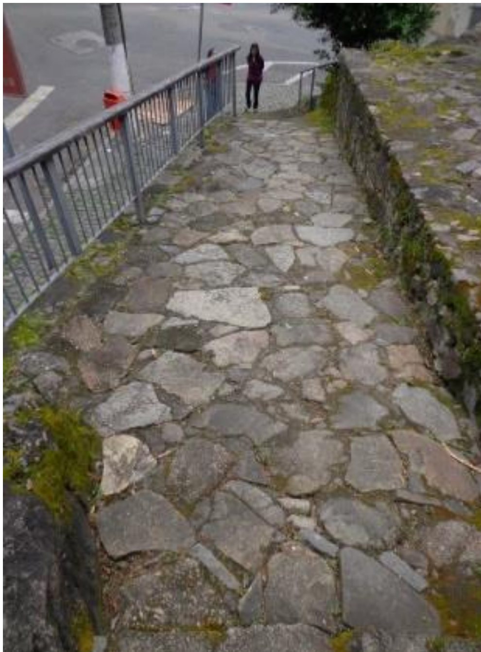
Figura 16 – Rampa de pedras que dá acesso à Capela de Santa Luzia. Centro Histórico de Vitória-ES
