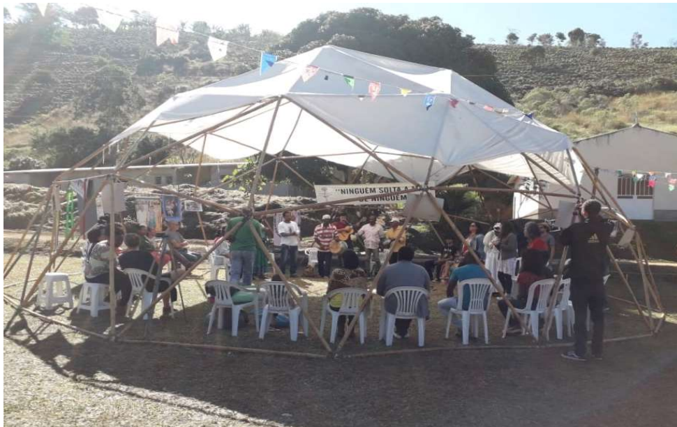
Figura 3 – Geodésica feita a partir do entrelaçamento do bambu. Fonte: Acervo da pesquisadora (2019).
