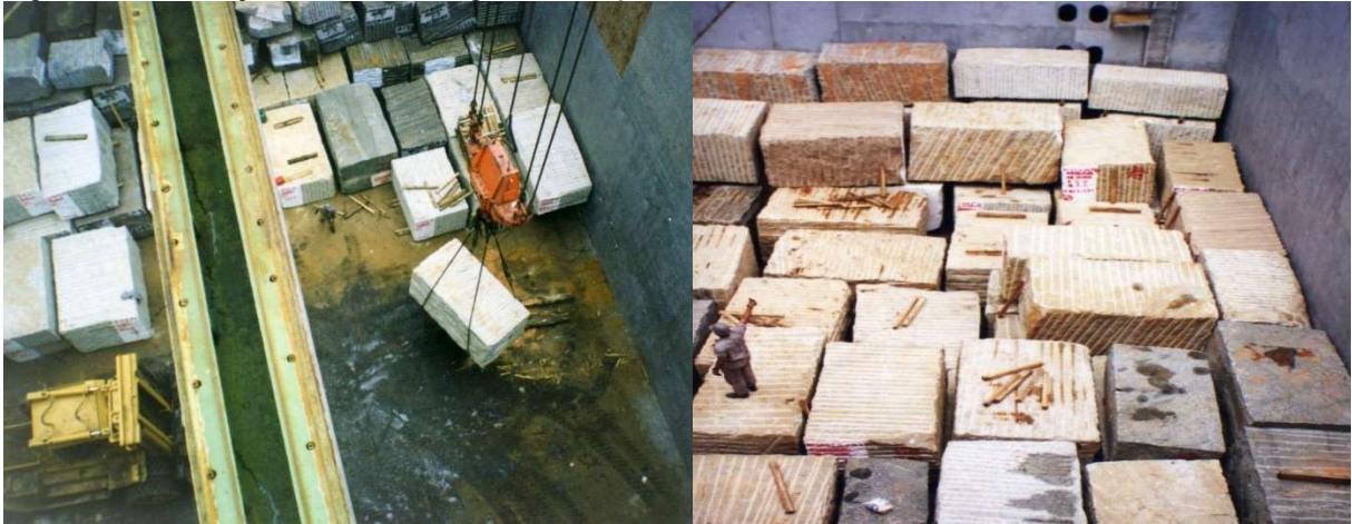
Figura 6 - Arrumação de blocos de granito em porões de navio
