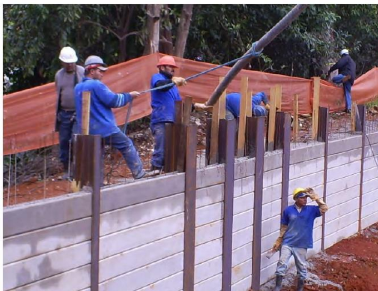
Figura 6 - Muro de contenção utilizando perfil metálico cravado e placas de concreto pré-moldado Fonte: Trombelle (2018)
