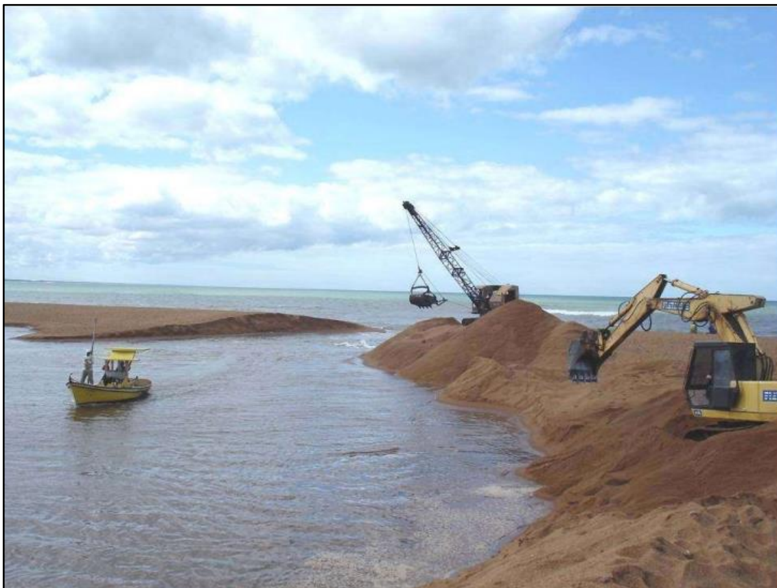
Foto 01: Máquinas da Prefeitura de Aracruz e da empresa Suzano S/A (então Aracruz Celulose) abrindo a barra do rio Riacho para passagem das embarcações, Barra do Riacho. Foto: Bruno de Laquila, 2007.
