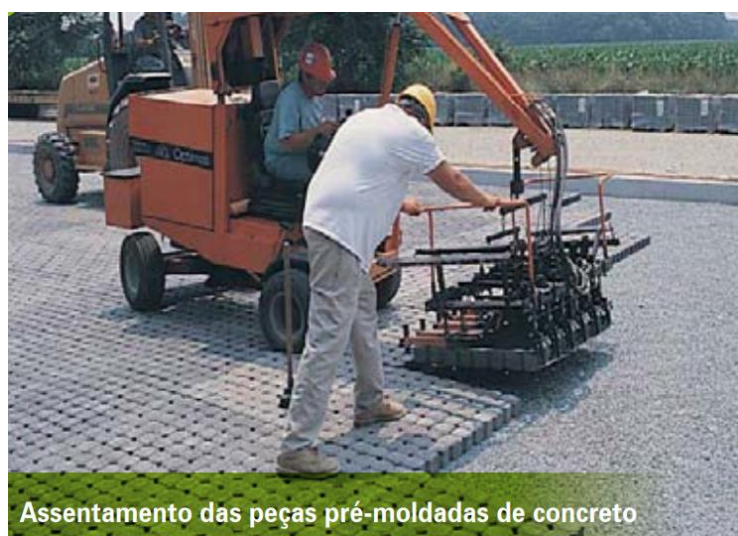
Figura 20 – Assentamento das peças pré-moldadas de concreto
