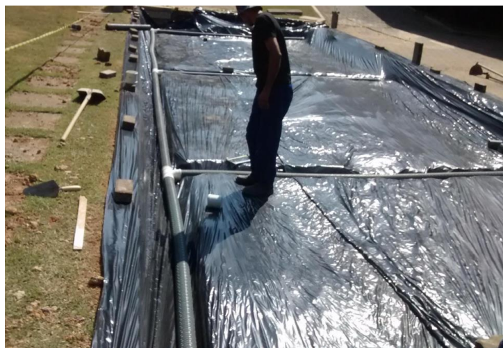
Figura 18 – Instalação dos drenos
