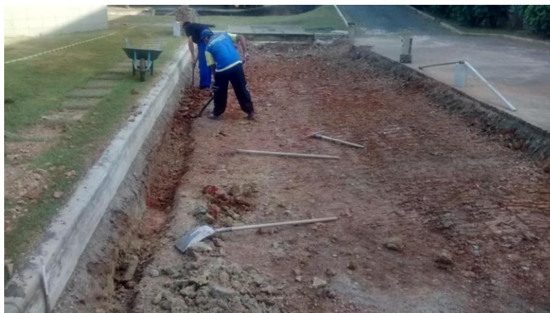
Figura 17 – Abertura de vala para instalação do dreno
