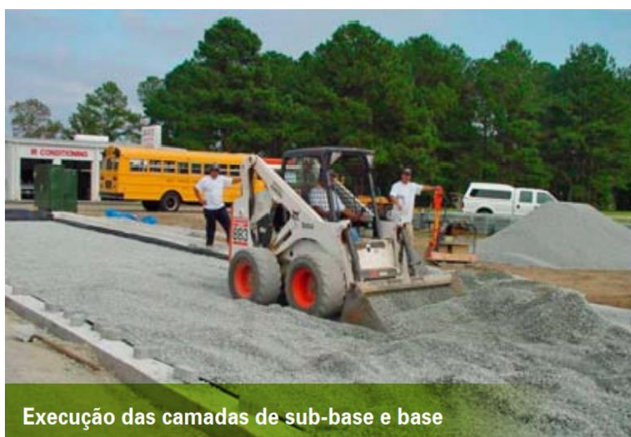
Figura 19 – Execução das camadas de sub-base e base
