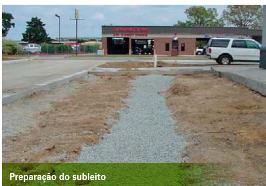
Figura 15 – Preparação do subleito
