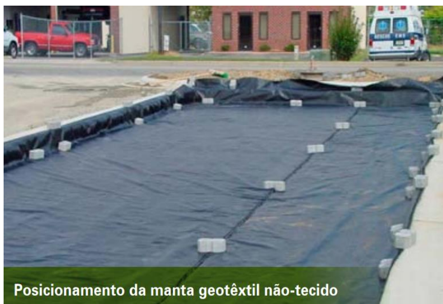
Figura 16 – Colocação da manta
