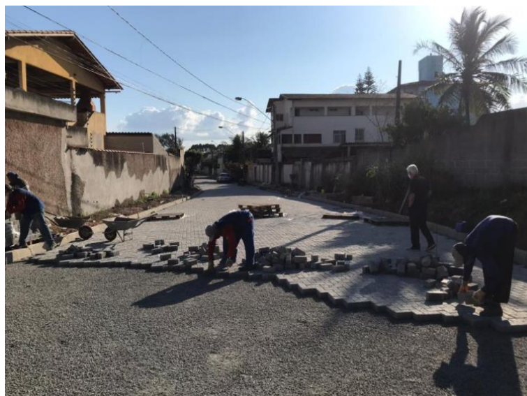
Figura 21 – Assentamento de blocos de concreto poroso no bairro Barra do Jucu, Vila Velha - ES
