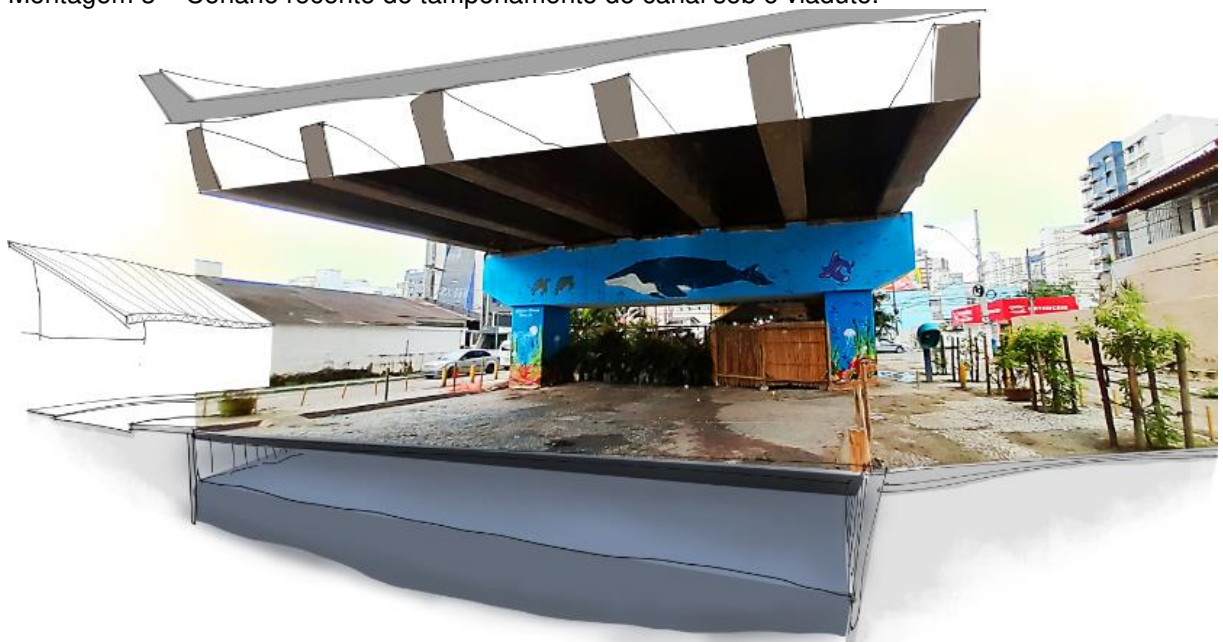
Montagem 3 – Cenário recente do tamponamento do canal sob o viaduto.
