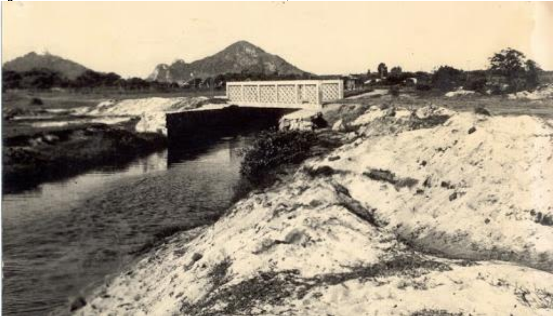
Fotografia 13 – Ponte concluída sobre o rio da Costa, na atual avenida Luciano das Neves.
