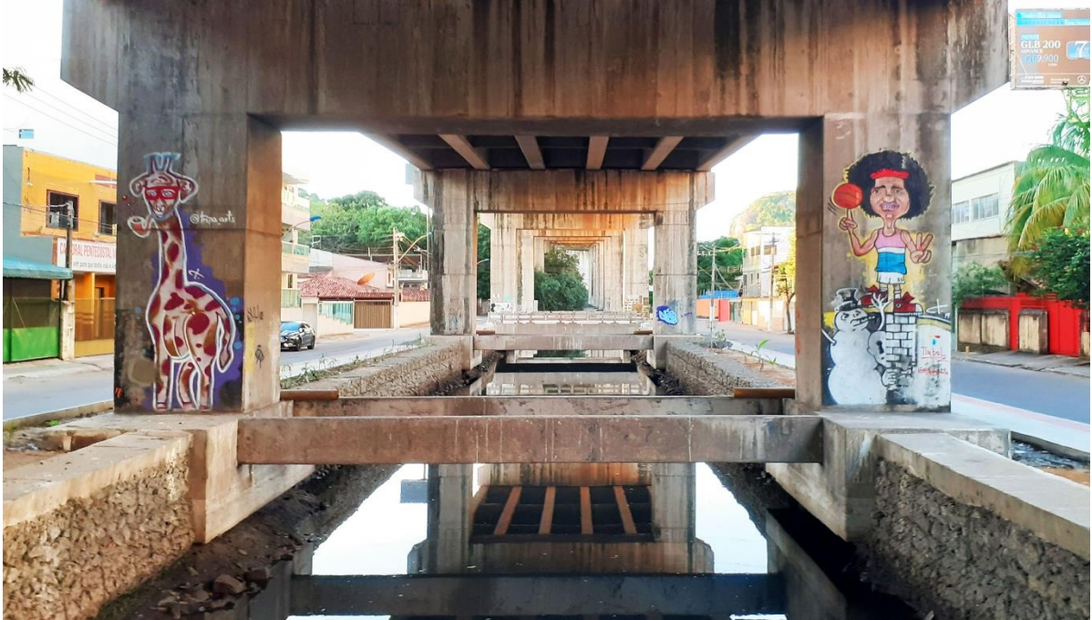
Fotografia 33 – Cenário recente das margens impermeabilizadas sob o viaduto.
