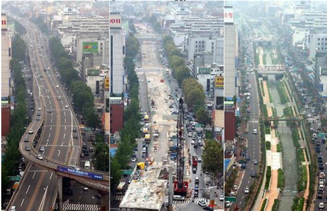
Fotografia 3 – Processo de recuperação do rio Cheonggyecheon.
