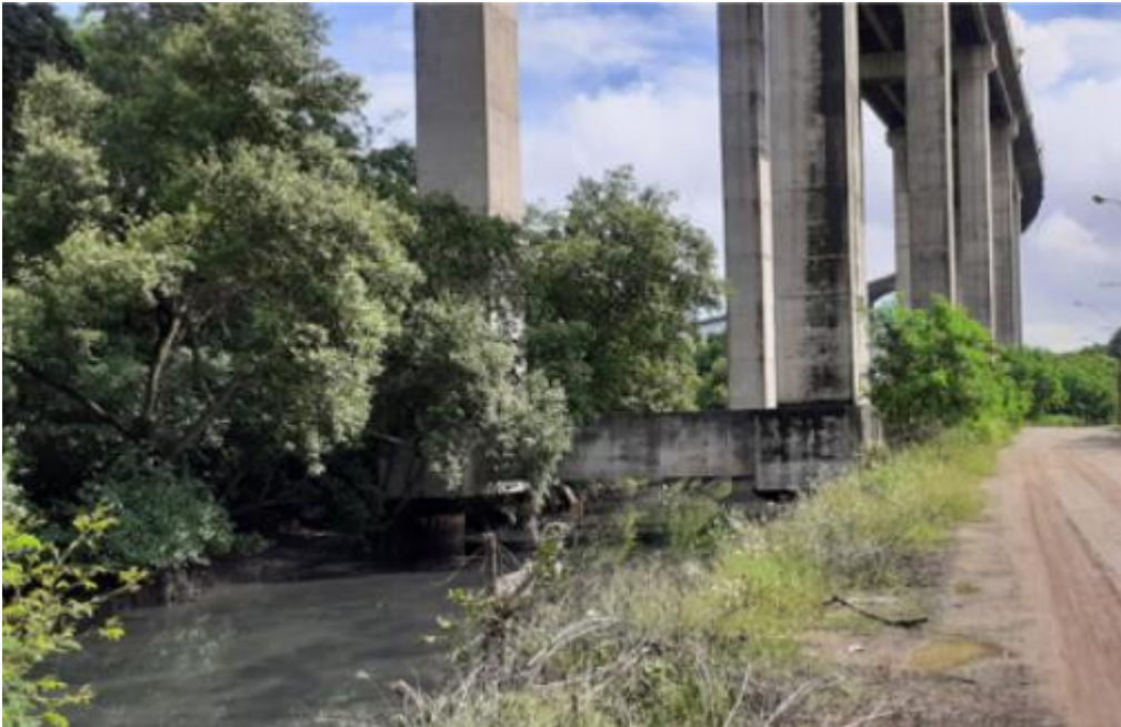
Fotografia 32 – Vista recente da foz do canal da Costa sob o viaduto da Terceira Ponte.
