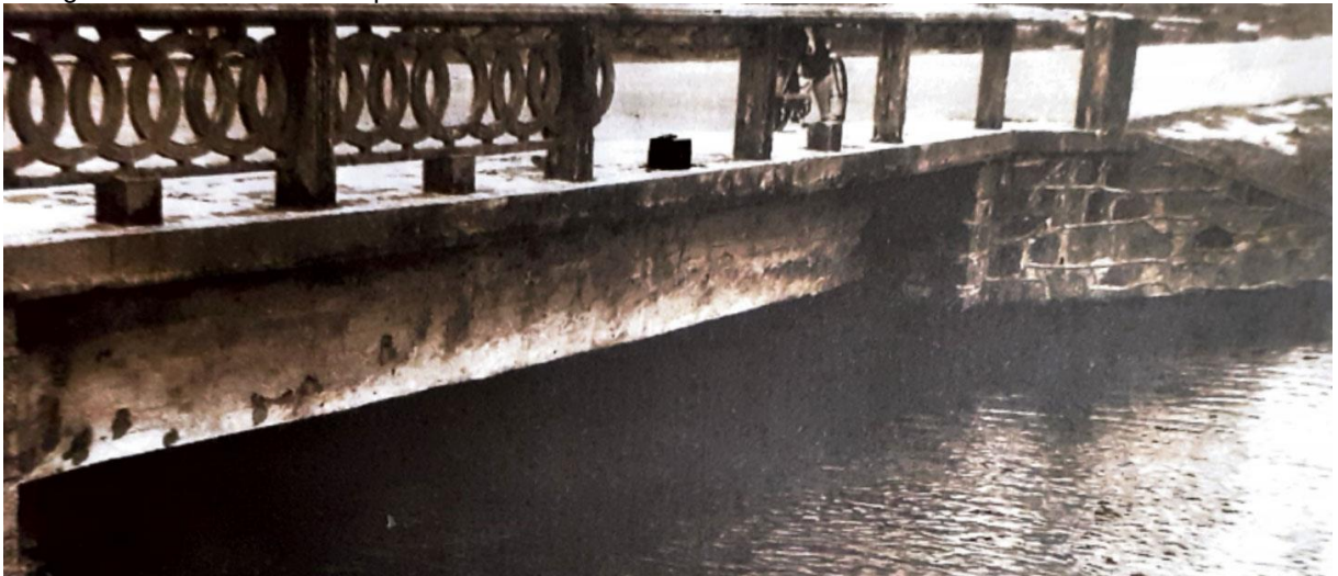
Fotografia 11 – Detalhes da ponte sobre o rio da Costa.
