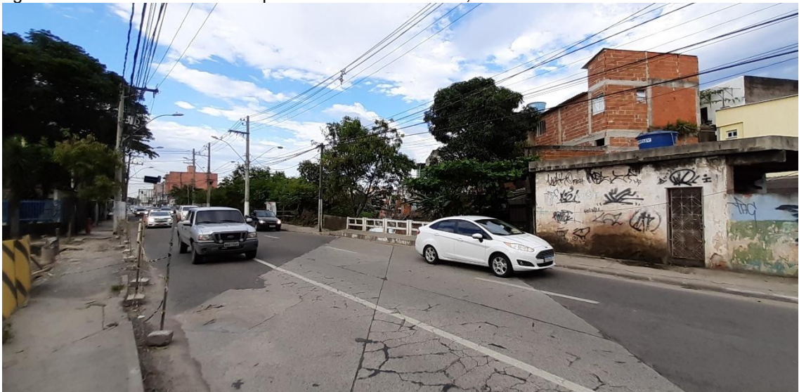
Fotografia 14 – Foto atual sobre a ponte no canal da Costa, na avenida Luciano das Neves.
