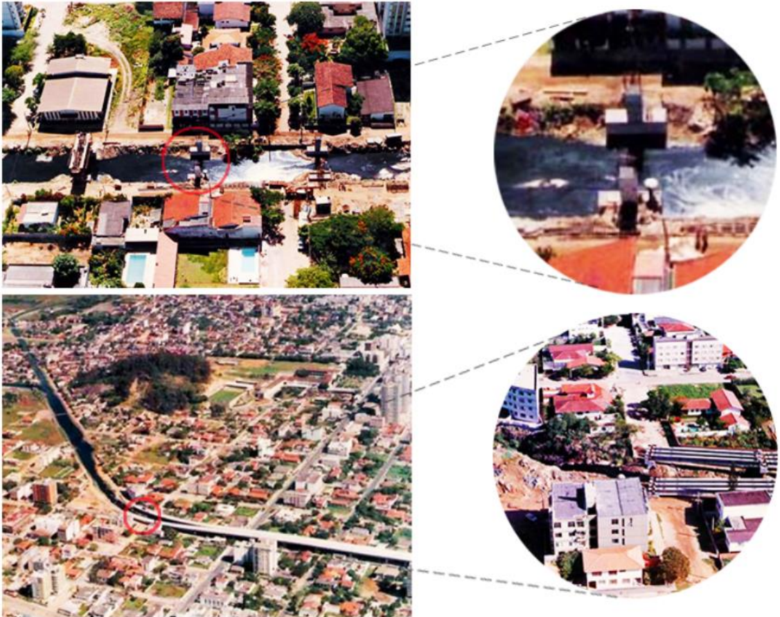
Montagem 1 – Construção da Terceira Ponte.
