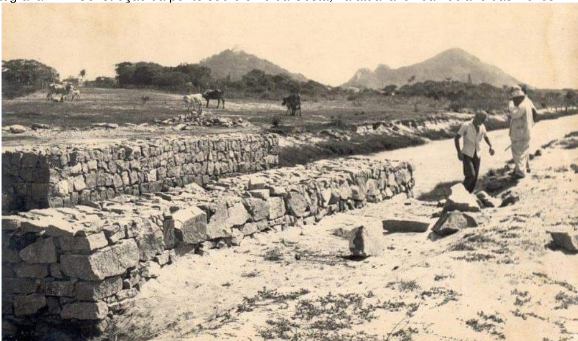
Fotografia 12 – Construção da ponte sobre o rio da Costa, na atual avenida Luciano das Neves.
