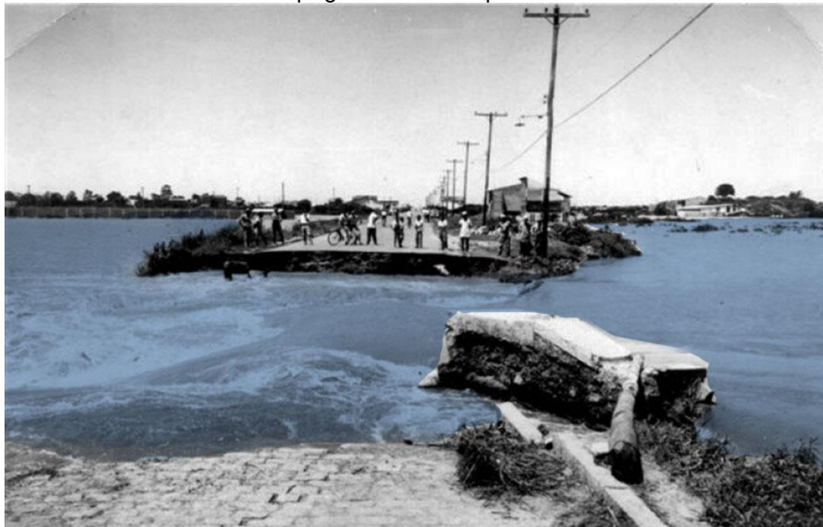
Fotografia 23 – Ponte na avenida Champagnat destruída pela enchente de 1960.
