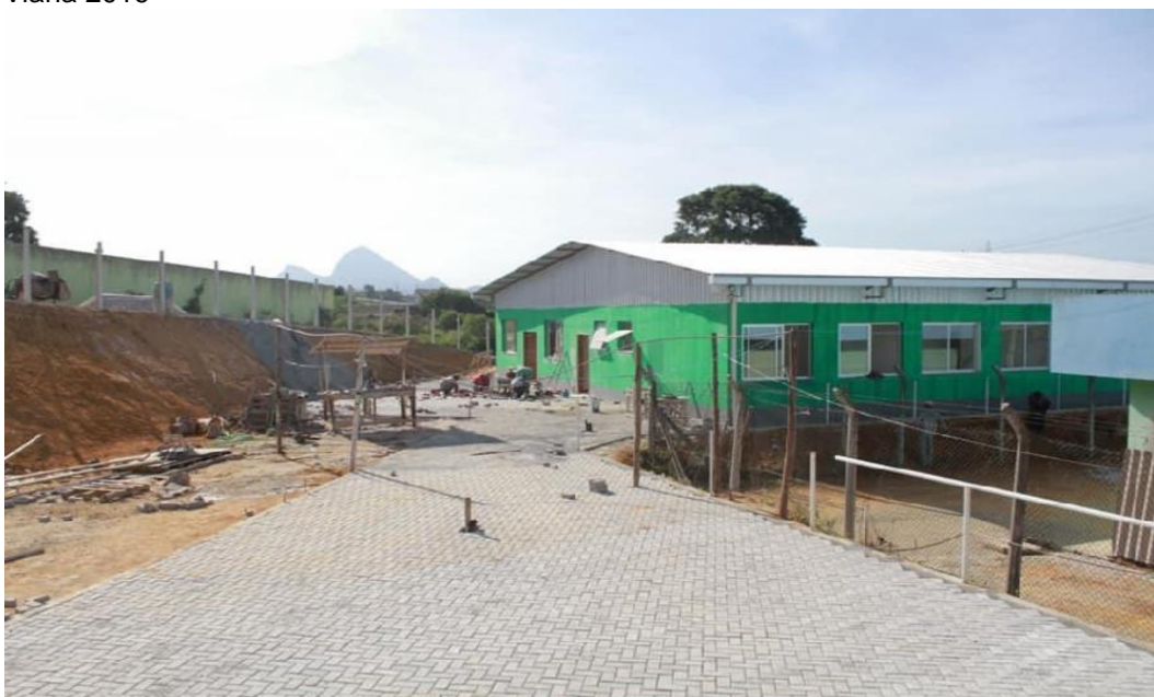
Figura 05: Centro de Convivência da Pessoa Idosa em construção – Campo Verde, Viana 2019
