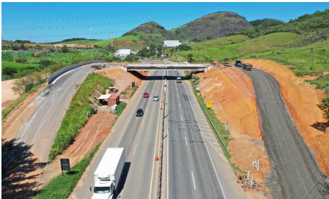
Figura 09: Viaduto sobre a BR 101/262 em Universal, Viana/2019
