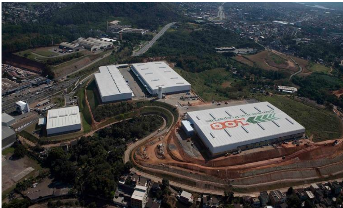
Figura 10: Galpões instalados às margens da BR 101 em Viana/2019
