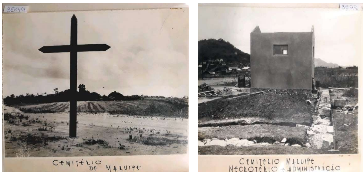
Figura 22 – Obras no cemitério de Maruípe (1958).
