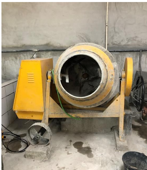
Figura 30 – Betoneira utilizada nas concretagens
