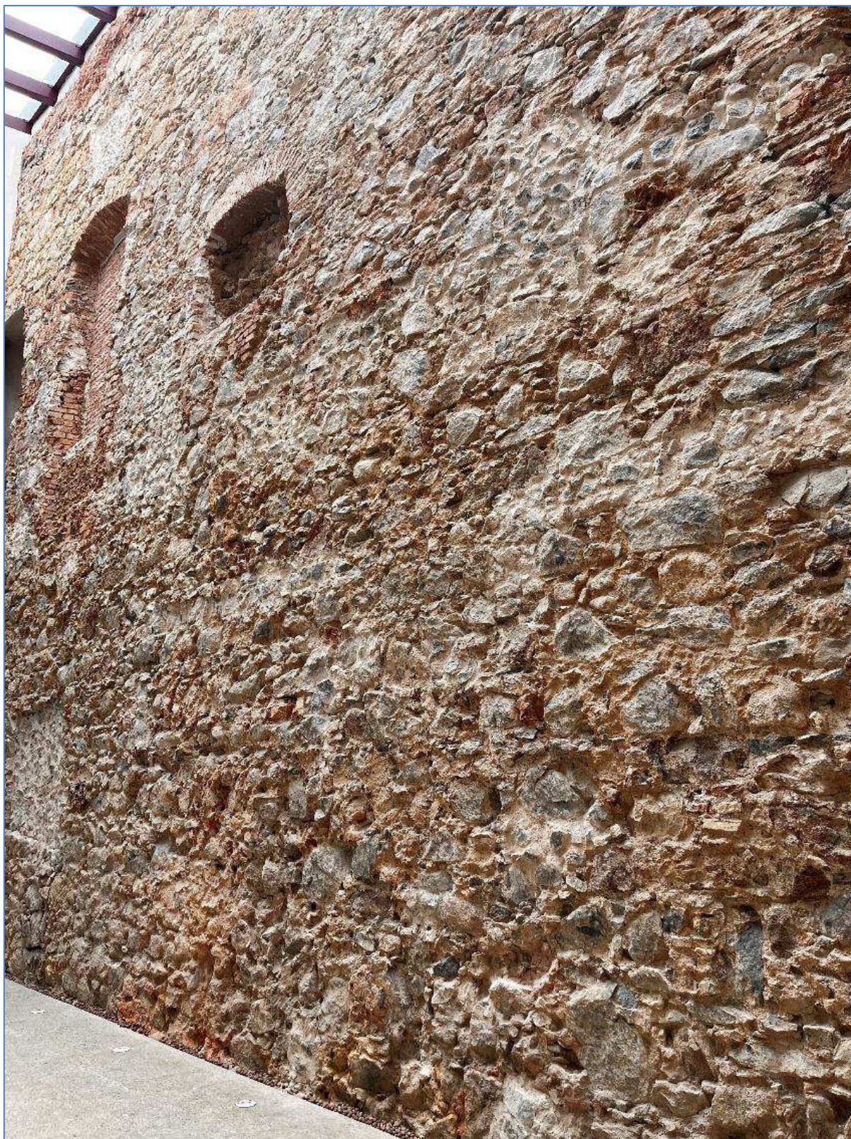
Figura 10 - Parede original do século XVI
