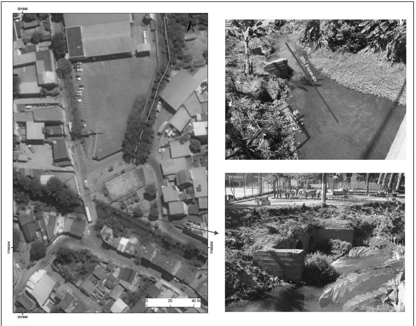
Figura 51 - Córrego parcialmente tamponado.
