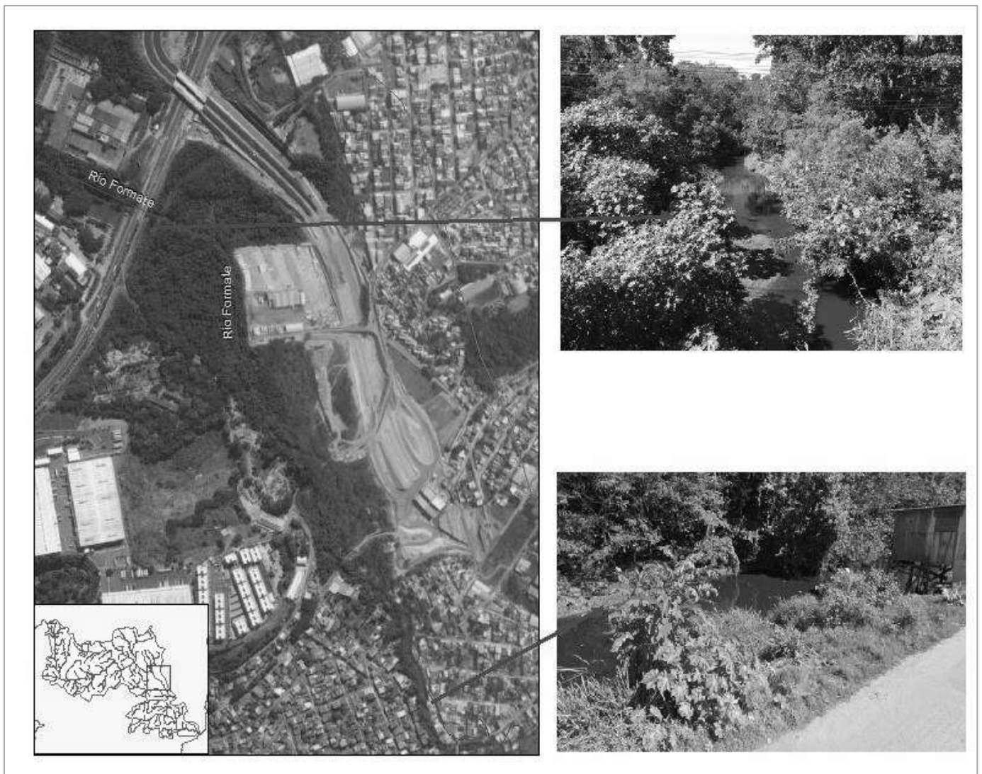
Figura 73 - Situação do rio Formate em alguns pontos.
