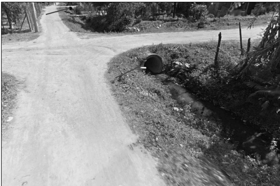
Figura 62- Captura de tela com visão a jusante evidenciando a canalização no Córrego Montanha.
