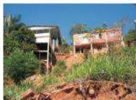
Lançamento de aterro na encosta e ameaça de desabamento de casas
