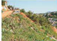
Lançamento de aterro, lixo e entulho, contribuindo para a desestabilização das encostas
