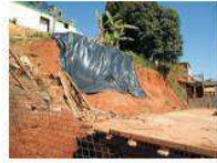
Utilização de lonas plásticas e gabioes para contenção de encosta
