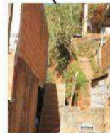
Acentuada declividade do terreno, com abertura de caminho por onde escoam as águas pluviais
