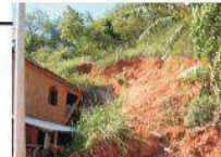
Moradia atingida por escorregamento
