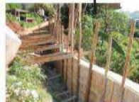
Obra de drenagem em andamento
