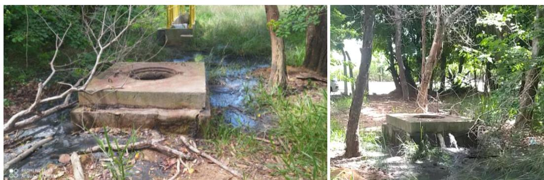
**Figura 13:** Vazamento de esgoto da ETE Cidade Continental.
