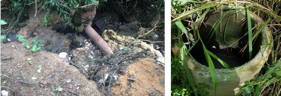
**Figura 4: Tubulação exposta e poço de visita sem tampa adequada**
