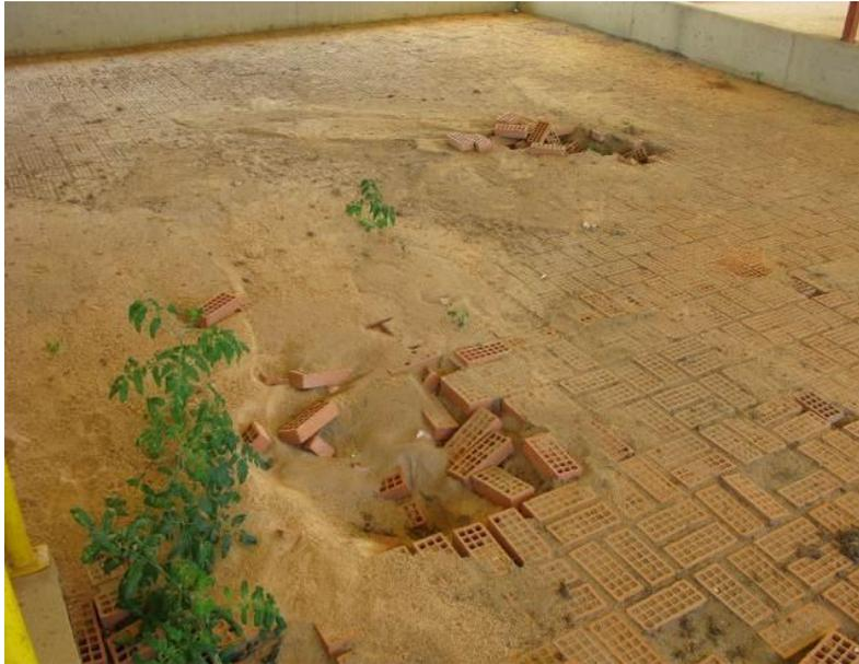
**Figura 6:** Leito de secagem danificado.
