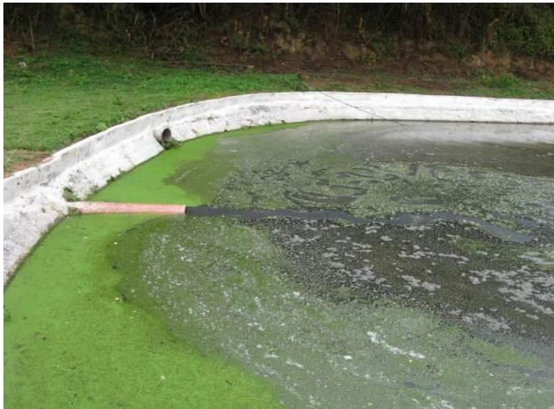
**Figura 7:** Material sobrenadante na lagoa de tratamento.
