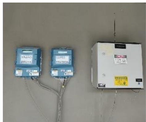
Instalação da telemetria
