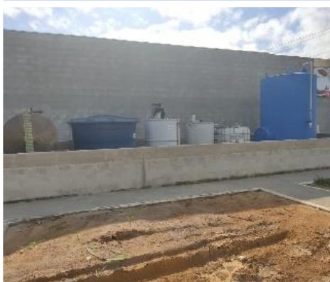
Construção do Tanque de Conteção dos Produtos químicos
