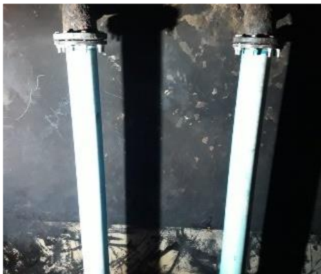
Troca da Válvula de Pé no reservatório
