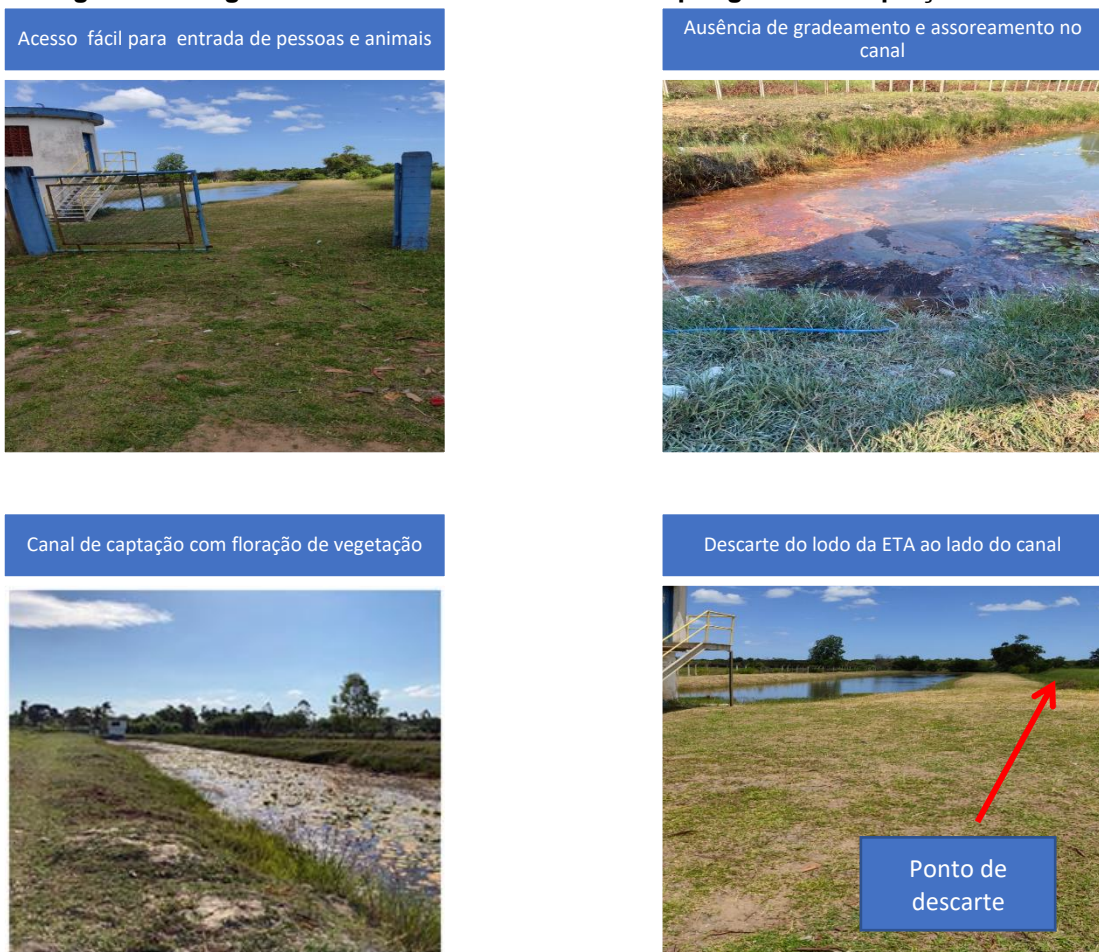
Figura 27 – Algumas das evidências dos eventos perigosos da captação do rio
