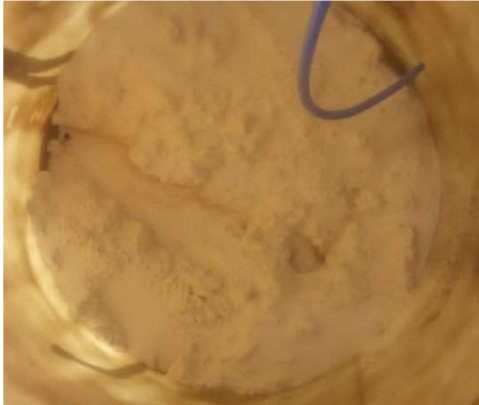
Acumulo de sedimentos no interior dos tanques de produtos químicos
