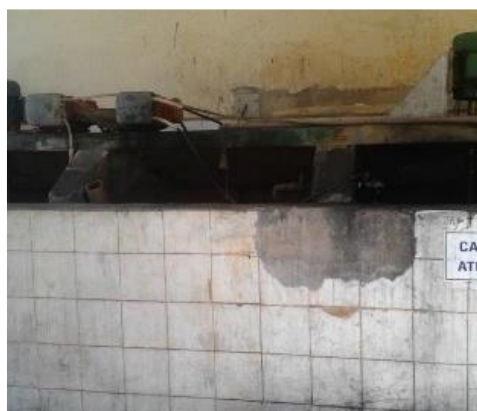
Vista da parte da estrutura da casa de química
