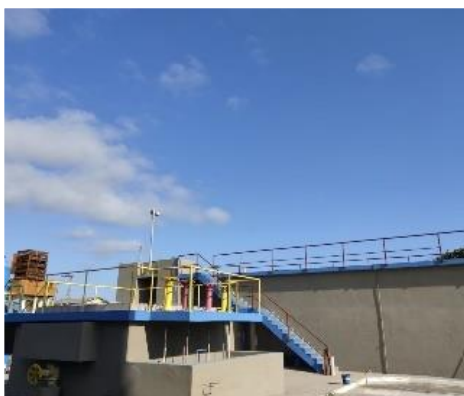
Reforma das unidades da ETA
