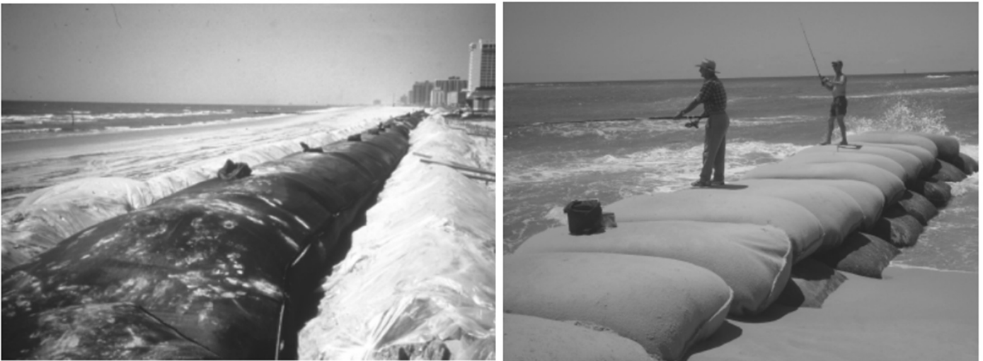
Figura 9 – Utilização de geotêxtis em obras hidráulicas costeiras.
