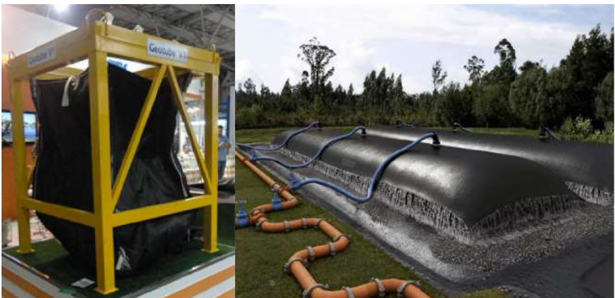
Figura 12 – Bolsas drenantes verticais e horizontais
