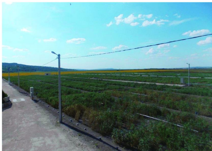
FIGURA 5: WETLAND CONSTRUÍDO DE ESCOAMENTO VERTICAL MODELO FRANCÊS PARA TRATAMENTO DE ESGOTO DOMÉSTICO EM ORHEI, MOLDÁVIA. FONTE: STEFANAKIS (2019).
