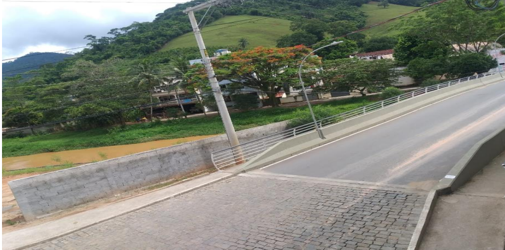
Figura 6 – Reconstrução da ponte localizada no centro da cidade
