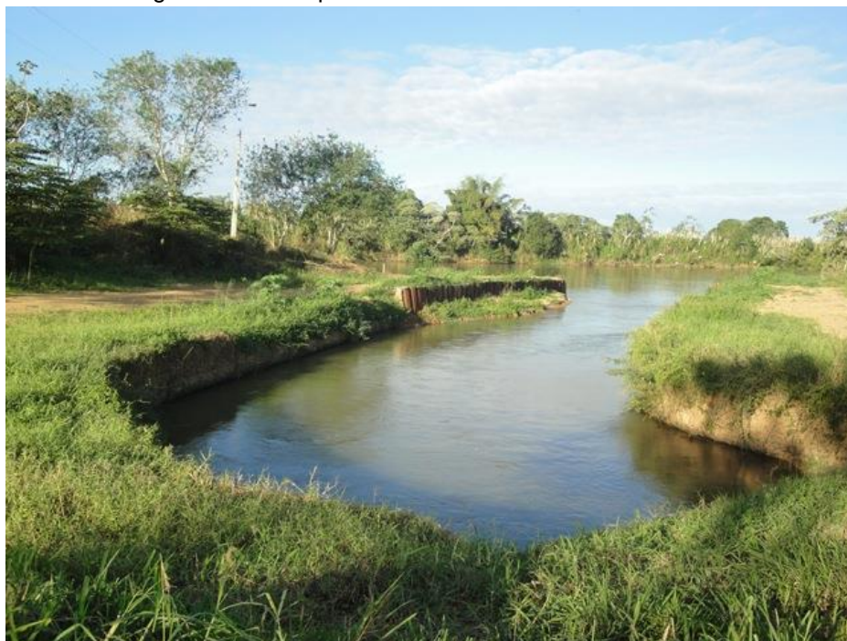
Figura 32 - Vista parcial do canal Caboclo Bernardo.
