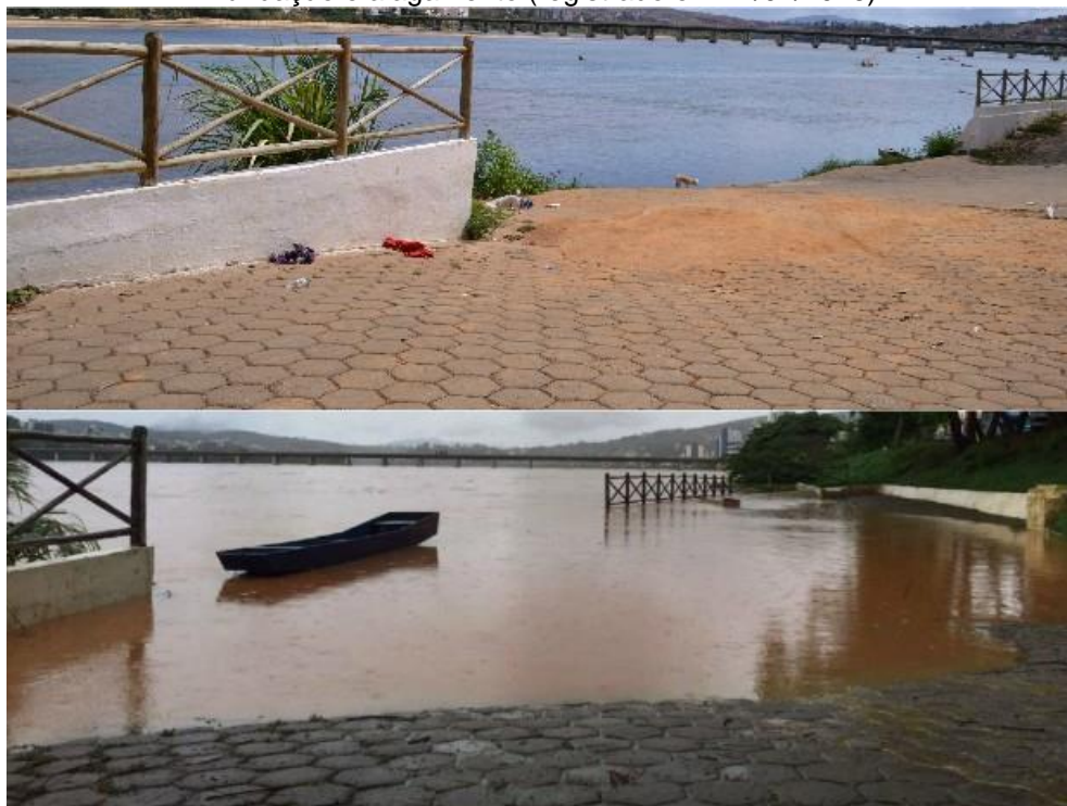
Figura 59 - Rio Doce em Colatina, representado em dois momentos: acima um período quando as águas estão no leito normal (registrado em 9/11/2015) e abaixo durante a cheia causando Inundação e alagamento (registrado em 21/01/2016).
