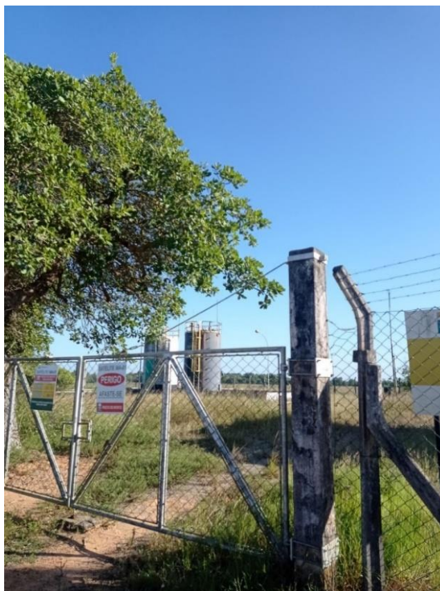
Figura 5 - Infraestrutura abandonada próximo à Mariricu, região de Guriri - São Mateus-ES.
