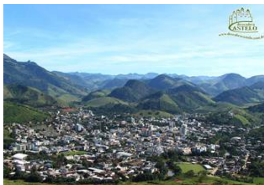
Figura 4 – Vista panorâmica da cidade de Castelo/ES
