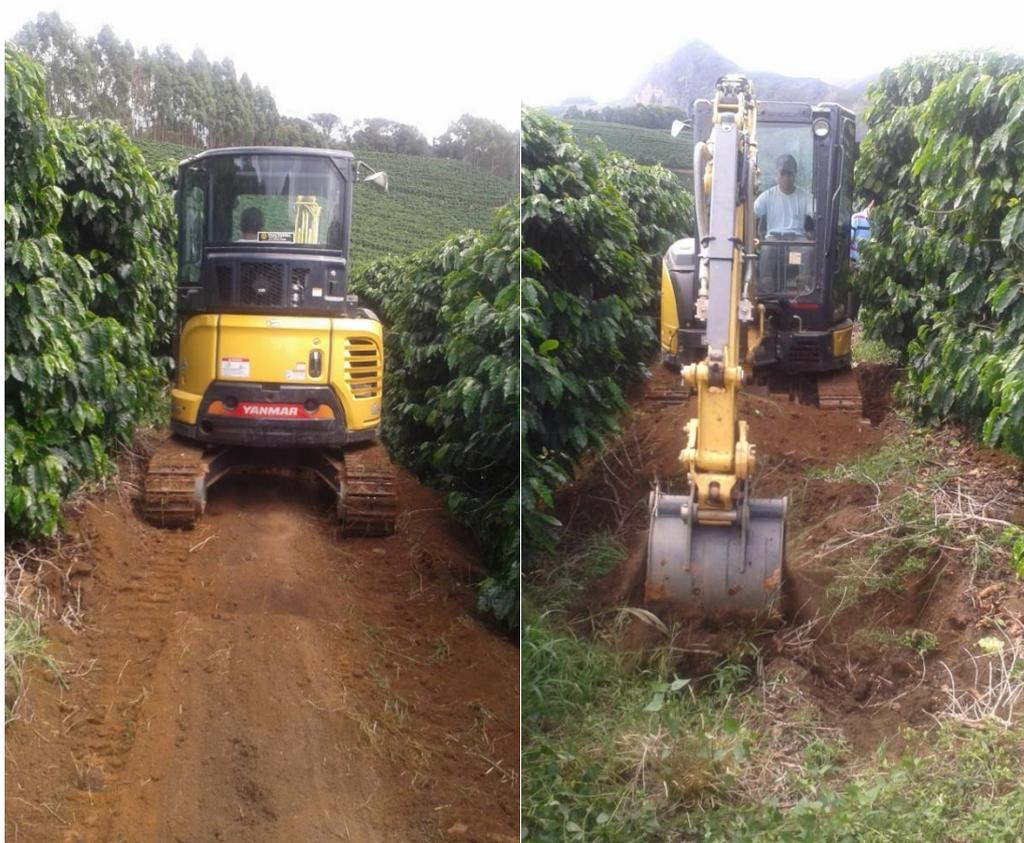
Figura 2. Abertura dos microterraços utilizando miniescavadora hidráulica.
