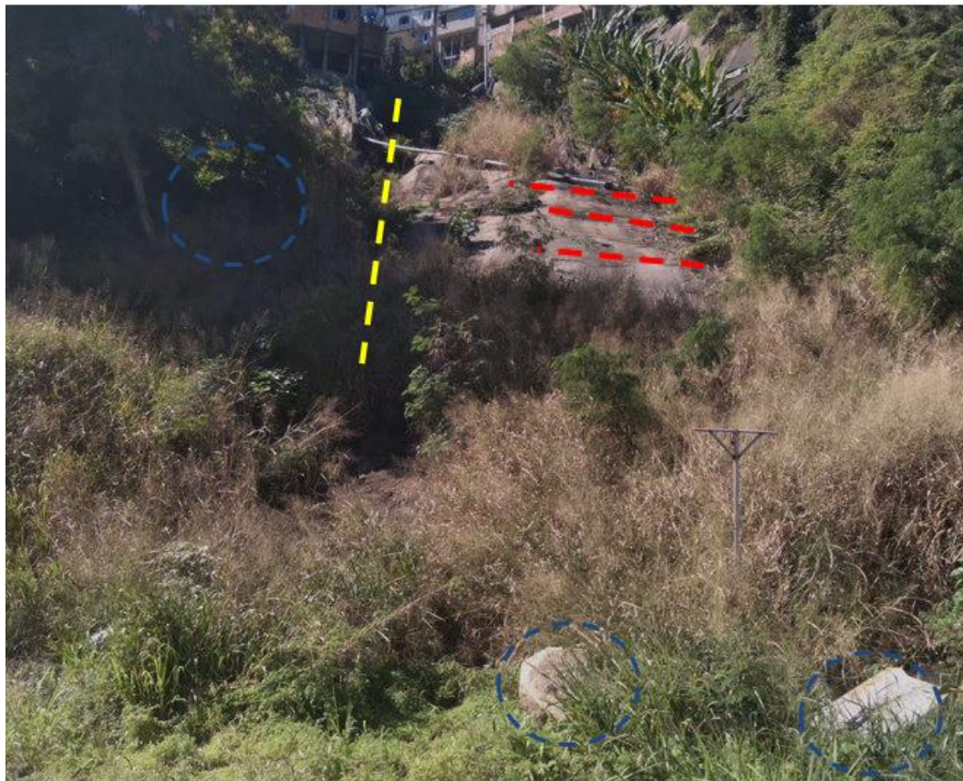
Figura 41 – Encosta situada em Caratoíra (Ponto 2), com a presença de fratura expressiva de orientação ENE-WSW (linha amarela), estruturas menores de orientação NNW-SSE (linhas vermelhas) e blocos rolados (circulados em azul).
