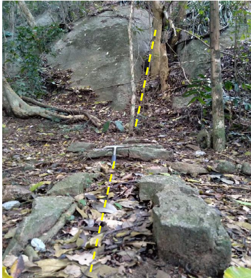
Figura 39 – Blocos rochosos fraturados no bairro Centro, Ponto 1. Fraturas demarcadas pelas linhas amarelas.
