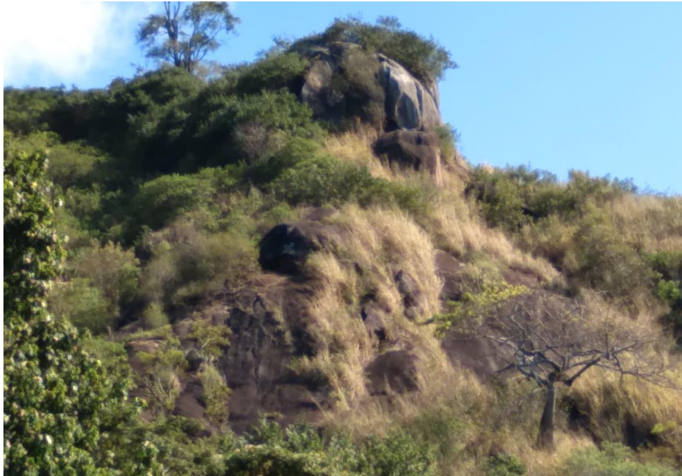
Figura 43 – Encosta com rochas fraturadas e processos de movimentos de massa.
