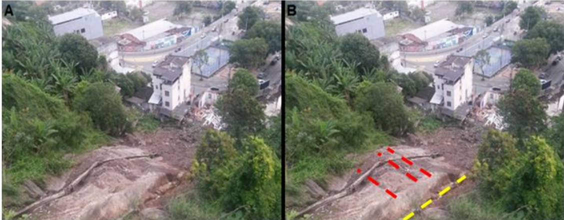
Figura 40 – A: Movimentos de massa em encosta no bairro Caratoíra (Ponto 2); B: Fratura expressiva de orientação ENE-WSW (linha amarela) e estruturas menores de orientação NNW-SSE (linhas vermelhas).
