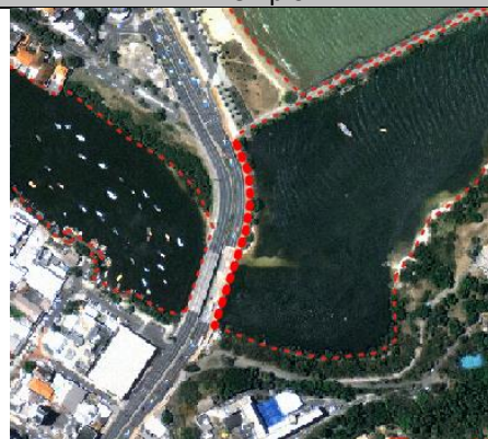
Segmento Ponte Ministro Petrônio Portela (Ponte de Camburi)
