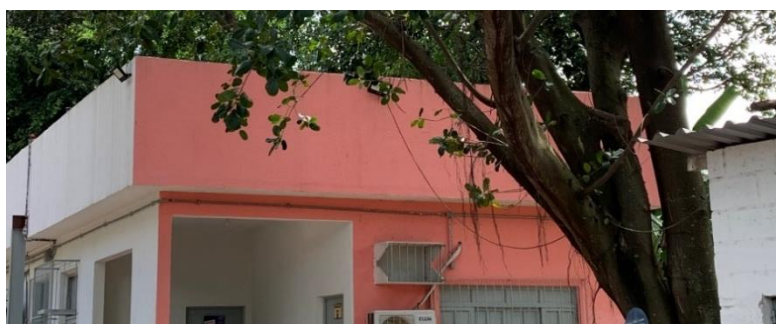
Figura 4 - Fachada do PAVÍVIS.
