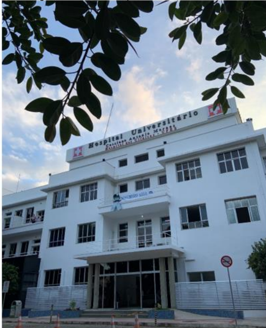
Figura 1 - Fachada do Hospital Cassiano Antônio Moraes.
