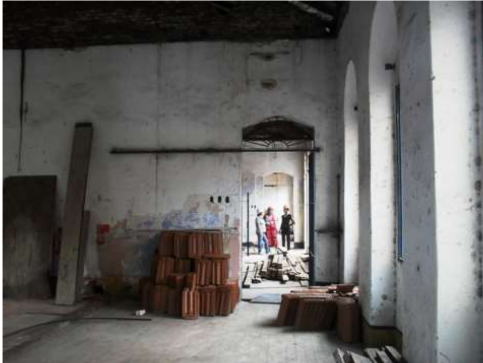
Figura 9: Vista interna do prédio nas obras de restauro do Museu Capixaba do Negro. Mucane, 2011. Crédito: Acervo pessoal de Vanda Vieira de Souza.
