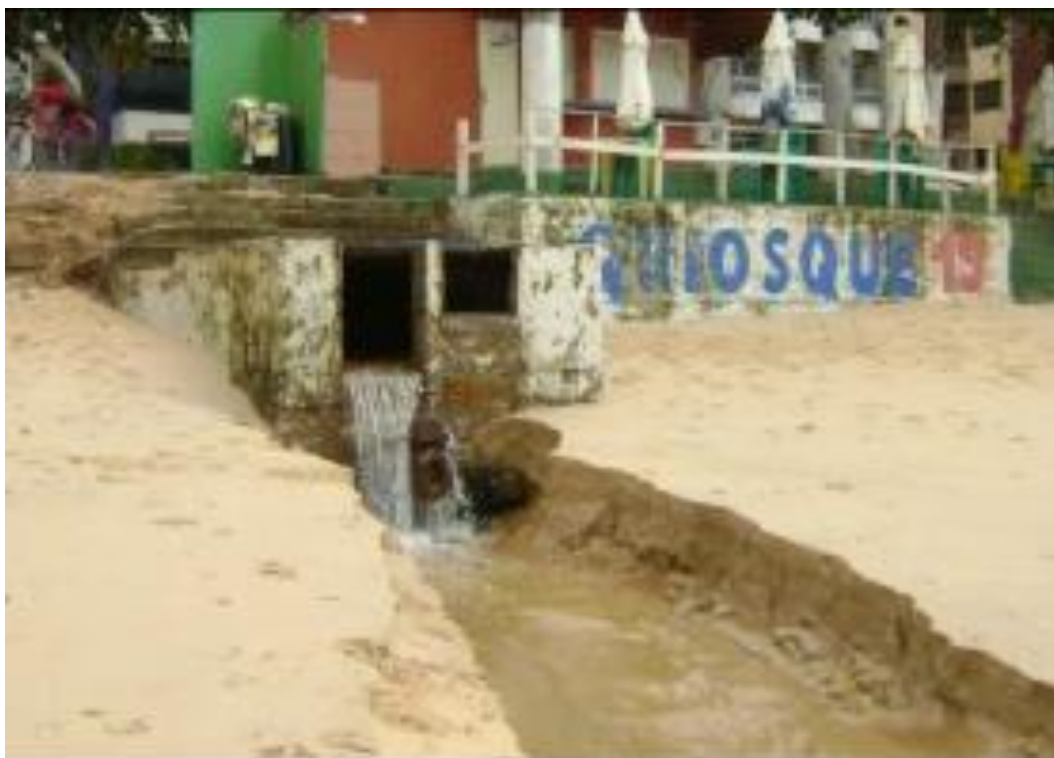
Figura 58- Sangradouro em calçadão da Praia do Morro.
