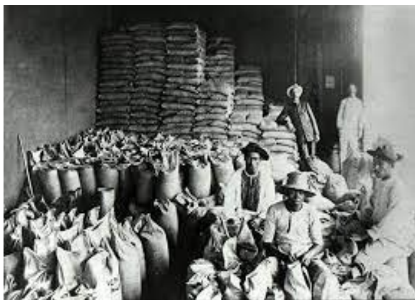
Figura 38 - Ensacamento das areias feito por trabalhadores
