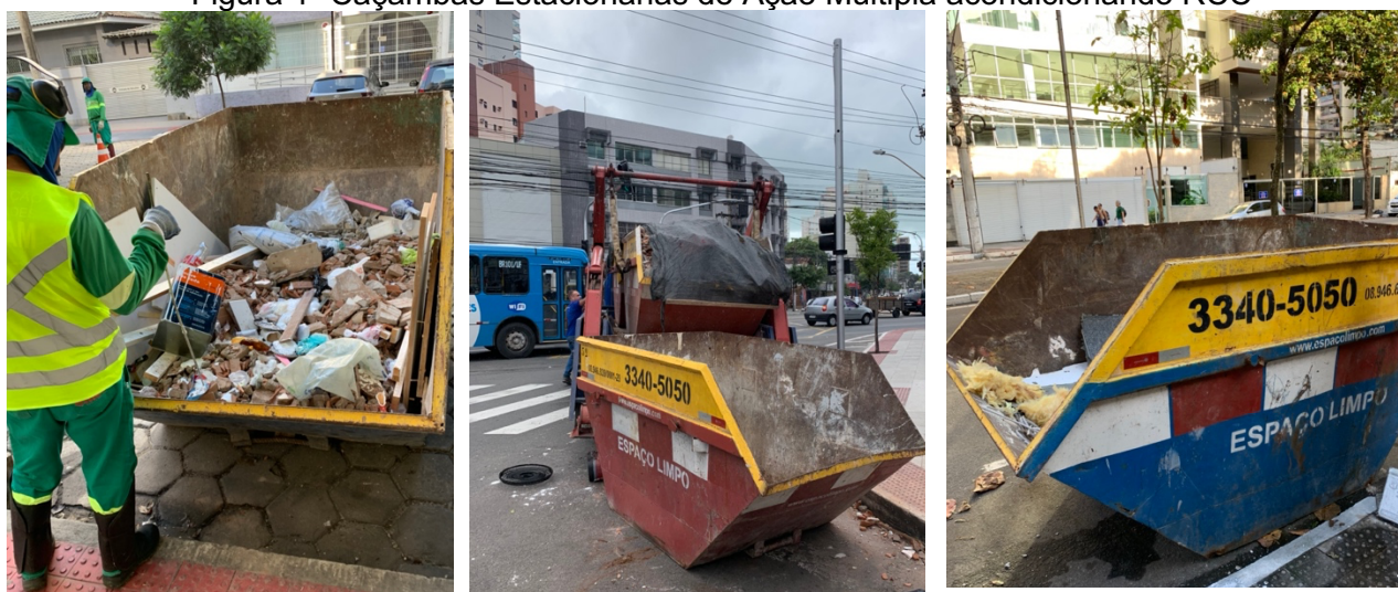
Figura 1- Caçambas Estacionárias de Ação Múltipla acondicionando RCC
