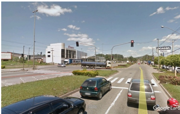
Figura 3.17. Rodovia federal BR-101 antes da construção do viaduto.
