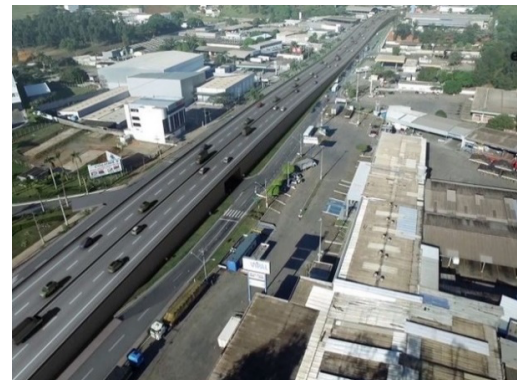
Figura 3.18. Rodovia federal BR-101 depois da duplicação.
