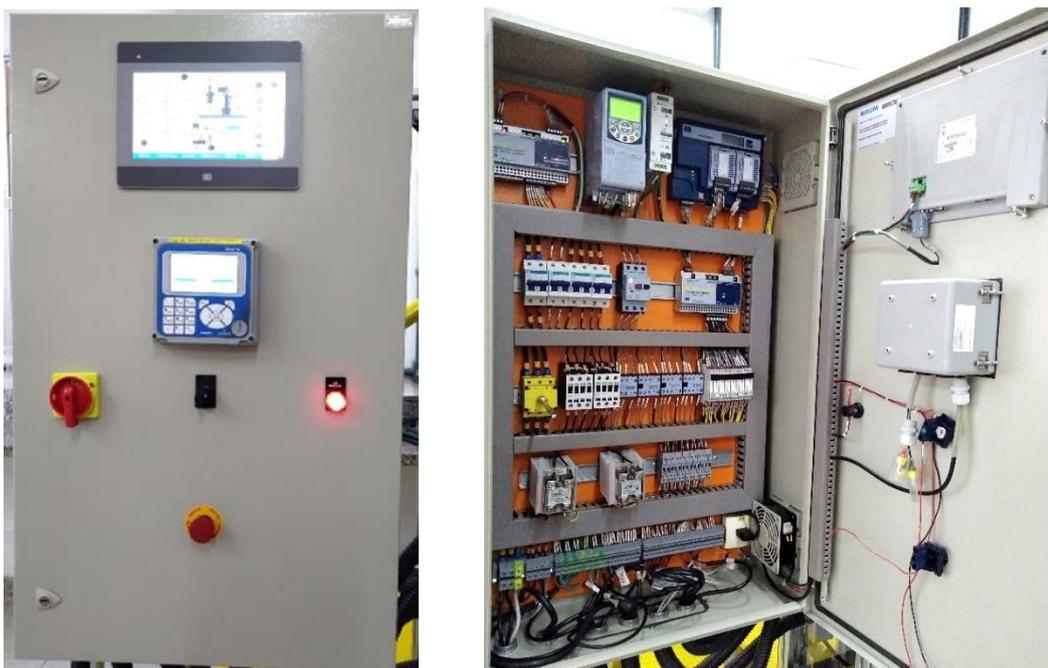
Figura 5.9. Painel elétrico de força e comando, incluindo a tela *touch screen* e a IHM do peagômetro.
