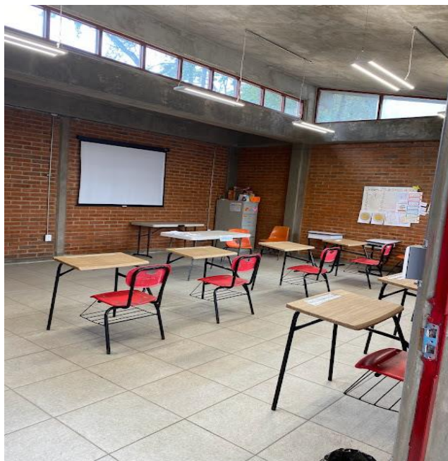
Figura 4 – Nova sala de aula construída no CAM
