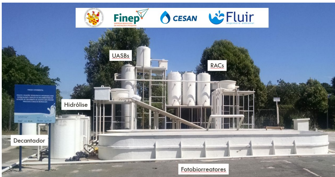
Figura 7 - Estrutura da ETE em escala piloto na área da ETE Araçás
