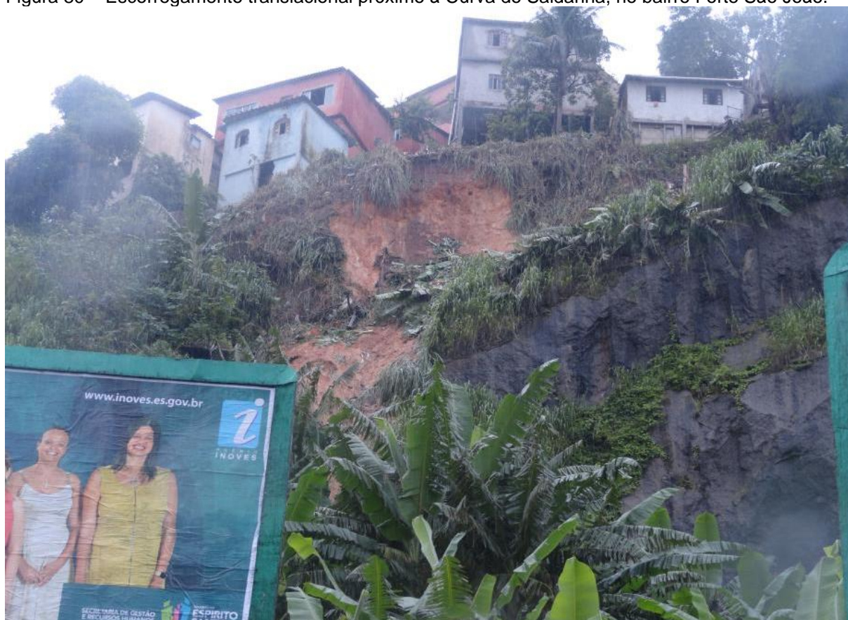
Figura 80 – Escorregamento translacional próximo à Curva do Saldanha, no bairro Forte São João.
