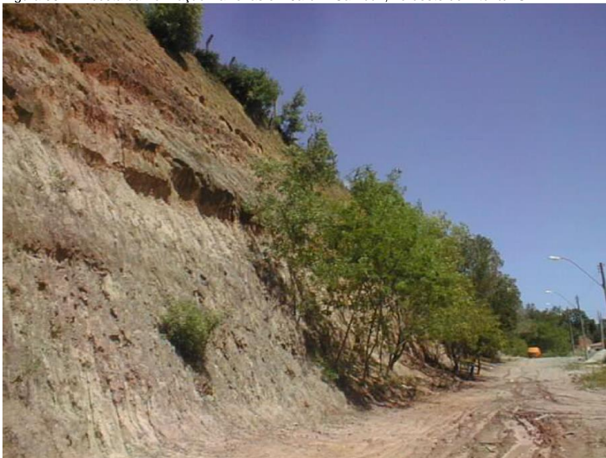
Figura 36 – Encosta da Formação Barreiras em Jardim Camburi, nordeste de Vitória/ES.
