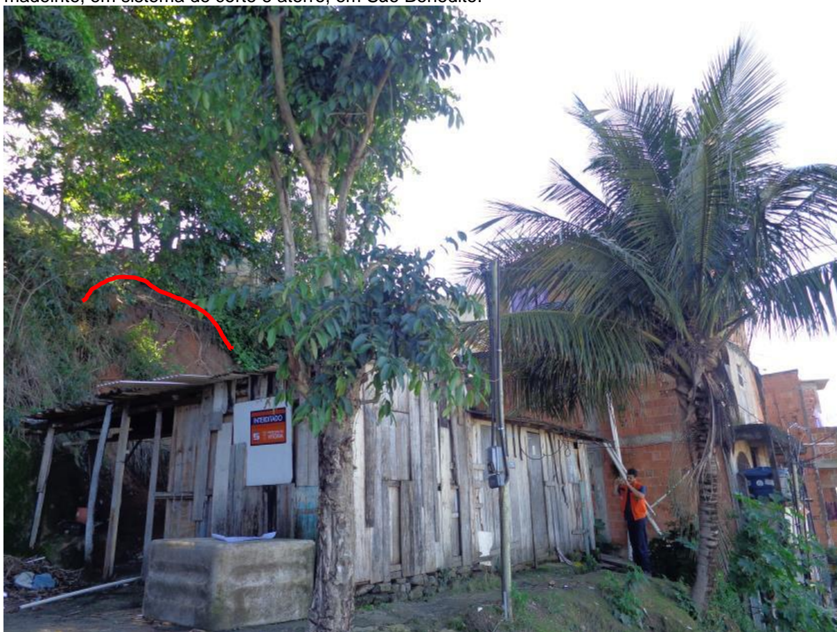
Figura 86 – Escorregamento translacional (destacado em vermelho) nos fundos de moradia de madeirite, em sistema de corte e aterro, em São Benedito.
