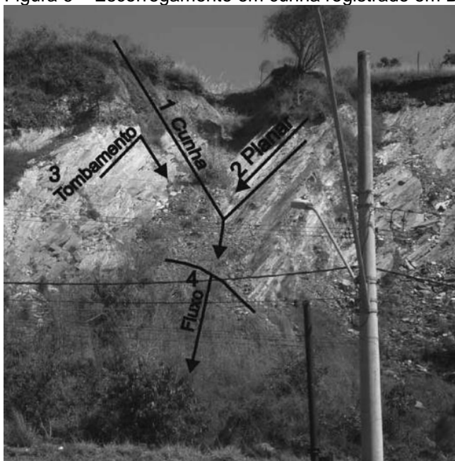
Figura 6 – Escorregamento em cunha registrado em Belo Horizonte, Minas Gerais.
