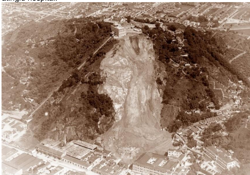
Figura 5 – Escorregamento rotacional no Monte Serrat, Santos-SP, em 1928. Material escorregado atingiu hospital.
