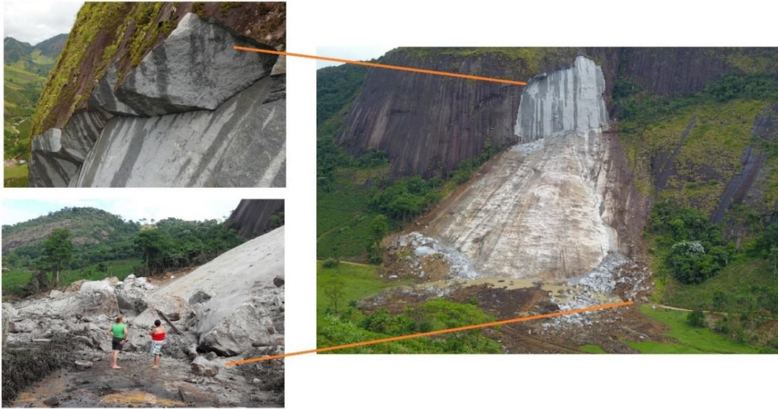
Figura 1: Queda de blocos: Desplacamento, ocorrido no dia 28 de janeiro de 2019 na localidade de Lembrança, Castelo/ES.
