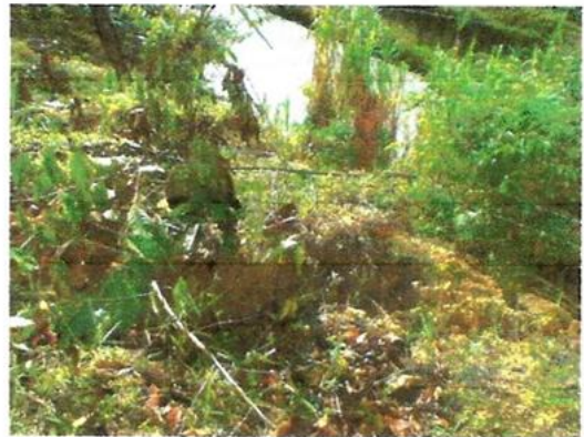
FOTO 02 – Fraturas que terminam na rodovia Pedro Cola, dentro da propriedade.
