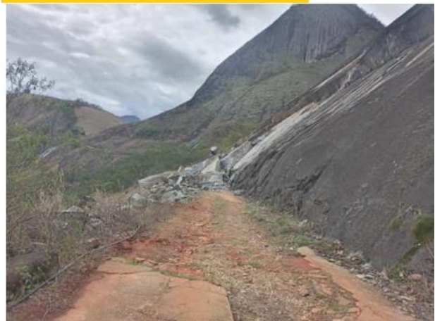
Foto B: Queda de blocos: deslocamento, 2022.
