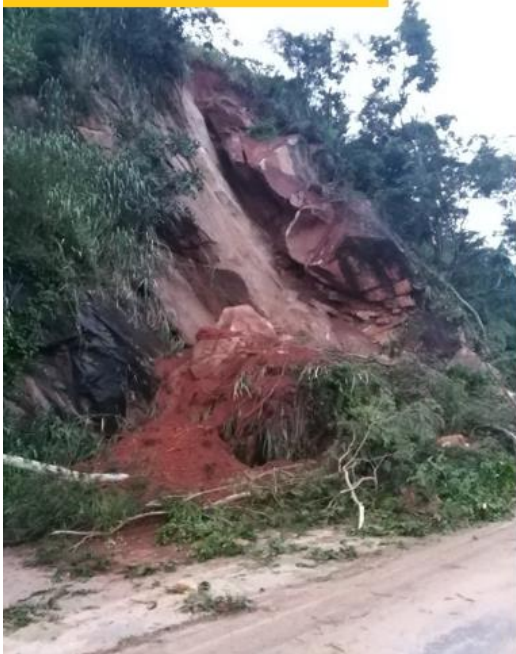
Foto A: Queda de blocos: rolamento, 2020.
