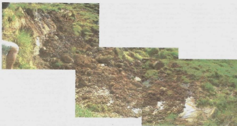
FOTO 06 – Fonte de água natural e infiltração imediata.
