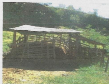
FOTO 10 – Curral inutilizado devido a movimentação do solo. Atentar para a subida do terreno.
