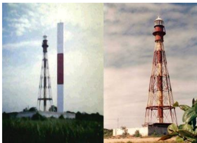
Figura 13: Antigo farol de Regência, cuja cúpula foi preservada e está exposta em uma praça. Em 1998 o farol foi desmontado e substituído por um novo, uma torre quadrangular em concreto. Ambos aparecem na foto da esquerda. Fonte: André Vargas (2021, p.191).
