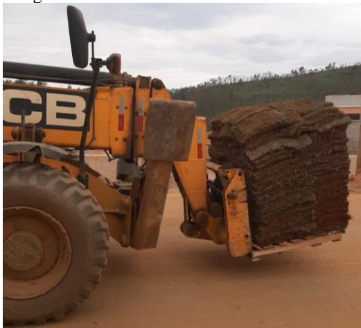
Fotografia 76 - Reassentamento de Bento em obras ainda em 2021
