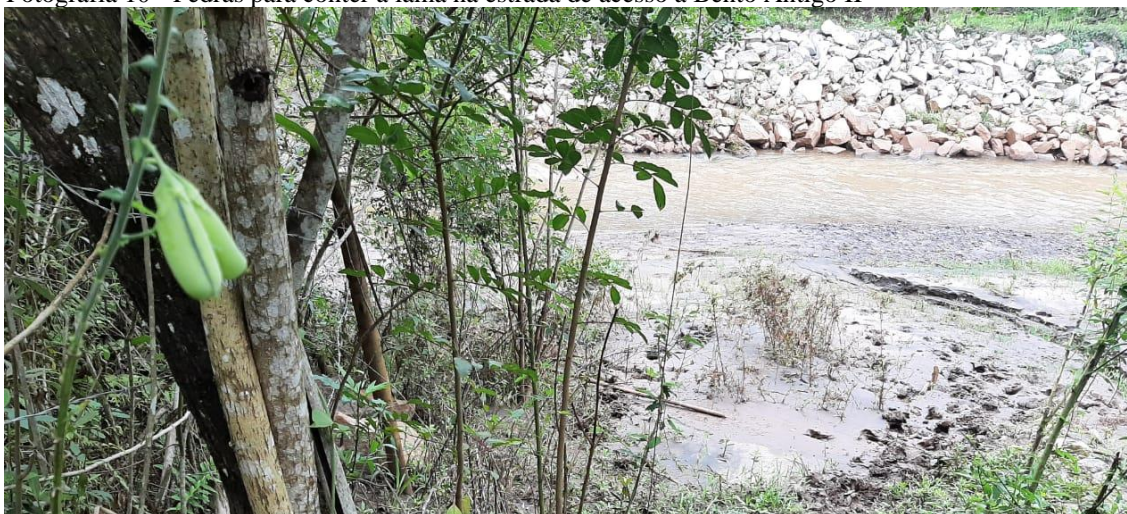
Fotografia 10 - Pedras para conter a lama na estrada de acesso a Bento Antigo II
