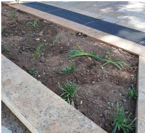
Fotografia 69 - Detalhes do canteiro e do calçamento da Praça pós-reforma
