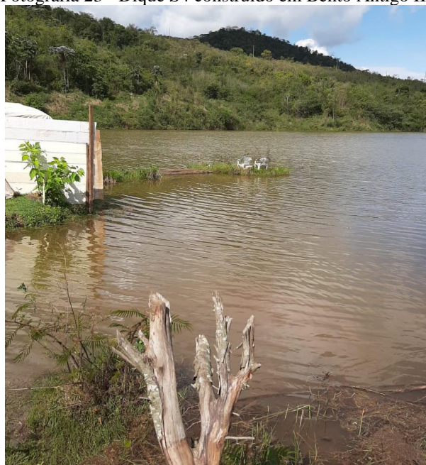
Fotografia 23 - Dique S4 construído em Bento Antigo II
