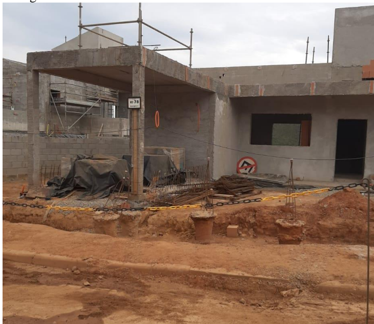
Fotografia 77 - Casa em obras em Bento Novo
