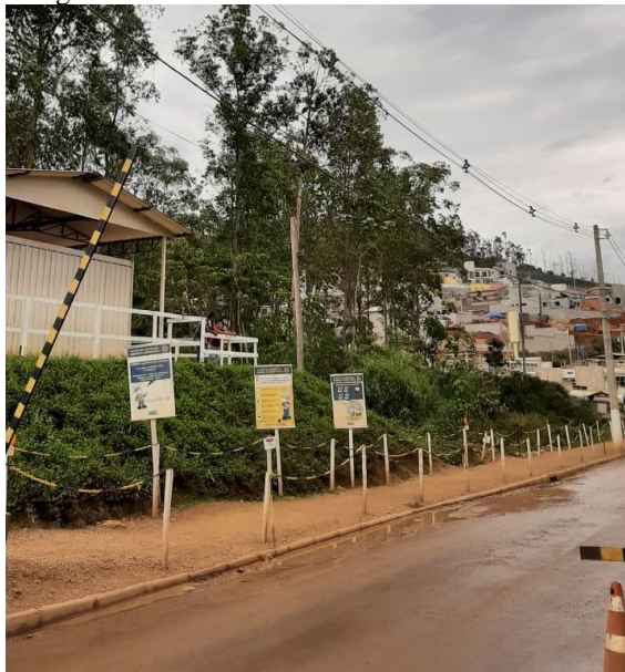
Fotografia 80 - Entrada Bento Novo em outubro de 2021
