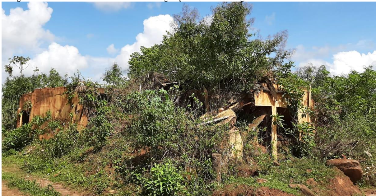
Fotografia 39 - Ruínas sendo camufladas com vegetação em Bento Antigo I
