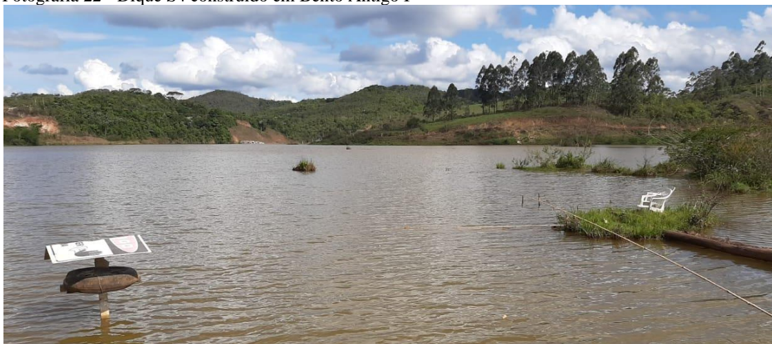
Fotografia 22 - Dique S4 construído em Bento Antigo I
