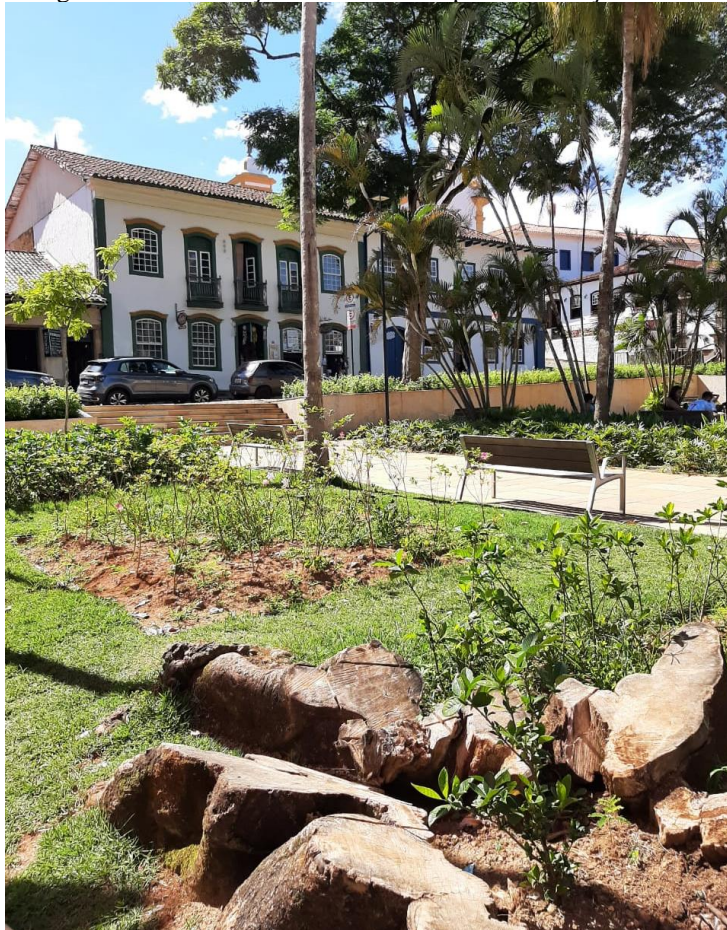
Fotografia 57 – Destroços do verde e das podas da Praça Gomes Freire
