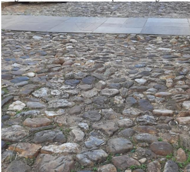
Fotografia 70 - Contraste entre calçamentos antigo e novo da Praça
