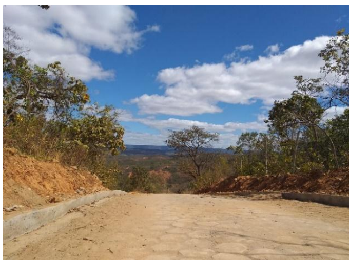
Figura 21 - Calçamento do morro da comunidade quilombola de Macuco
