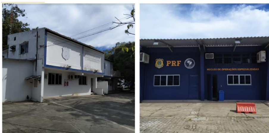
Figura 15 – Sede Operacional da Polícia Rodoviária Federal no Espírito Santo
