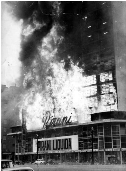
Figura 9: incêndio Edifício Andraus. (Fonte: https://pt.wikipedia.org/wiki/Inc%C3%AAndio_no_Edif%C3%ADcio_Andraus . Acessado em 25 de jul. 2022)
