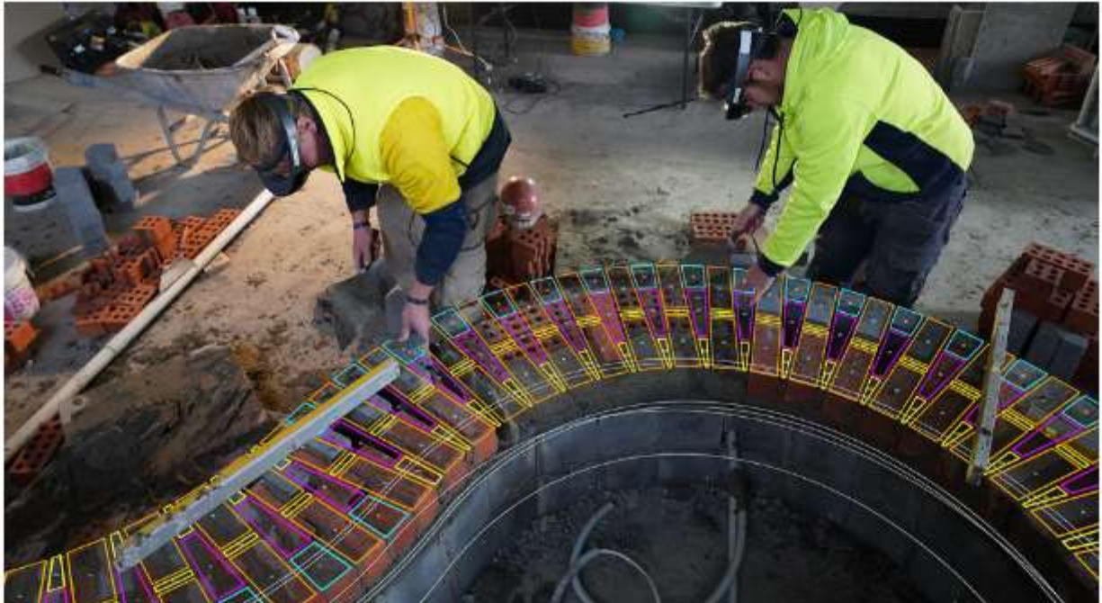
Figuras 35 e 36 - Uso do Fologram para executar uma muro em bloco cerâmico
