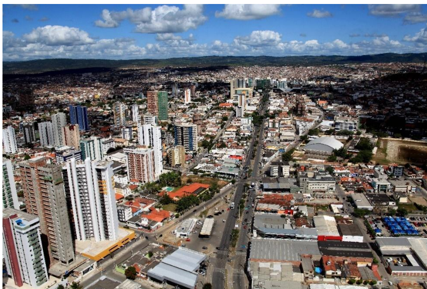
Figura 58: Avenida Agamenon Magalhães, rumo ao Centro Urbano Original (2012).
