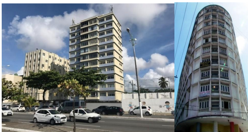
Figura 03: À esquerda, Edifício São Carlos. À direita, Edifício Breda.
