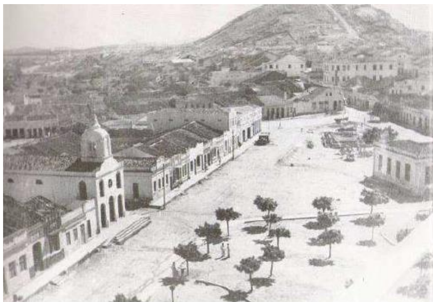
Figura 18: Antiga Praça Sérgio Loreto e Igreja do Rosário, à esquerda, demolida;
