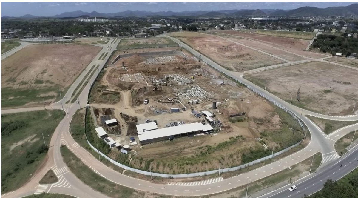
Figura 24 – Rodovia Leste-Oeste e construção do Hospital Geral de Cariacica (2021)
