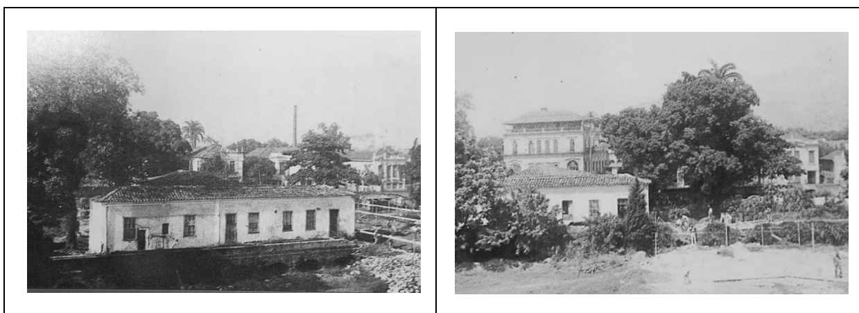
Figura 12 – Demolição da Escola Normal de Artes e Ofícios - Figura 13- Demolição da Escola Normal de Artes e Ofícios.
