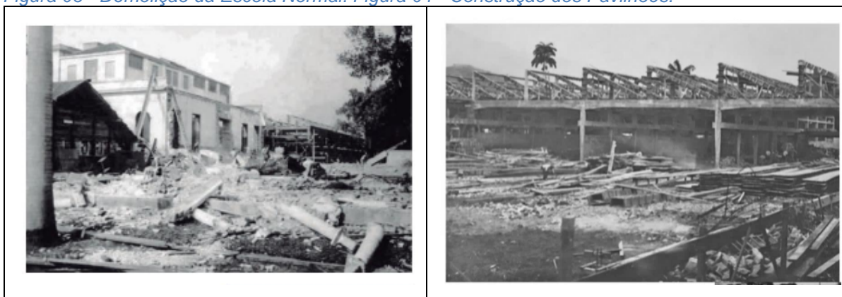
Figura 03 - Demolição da Escola Normal. Figura 04 - Construção dos Pavilhões.
