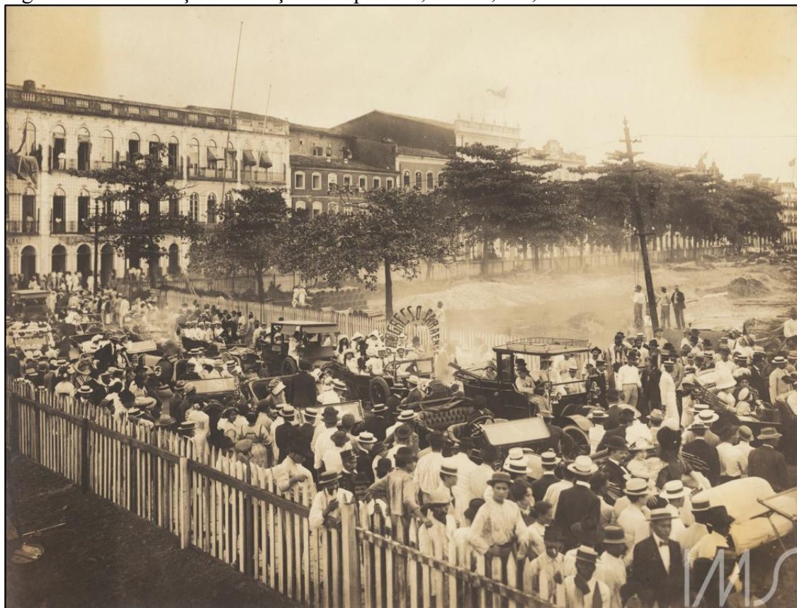
Figura 16 - Construção da Praça da República, Belém, PA, 1910 c.
