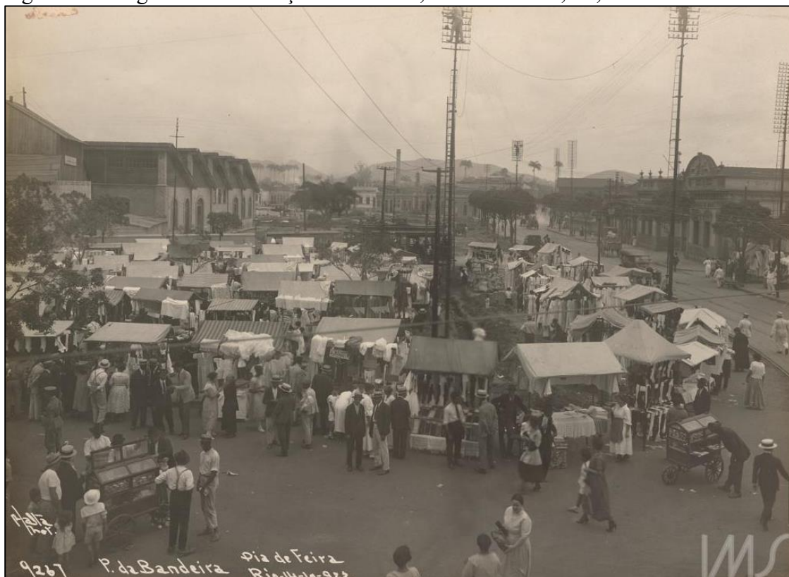
Figura 62 - Augusto Malta. Praça da Bandeira, Rio de Janeiro, RJ, 1922
