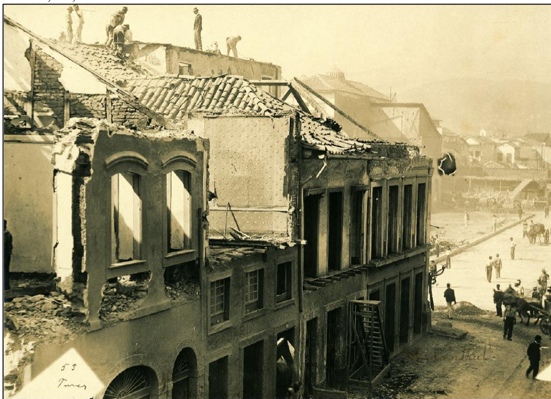
Figura 9 - Demolição de cortiços para início das obras da Avenida Central, Rio de Janeiro, RJ, 1900 c.
