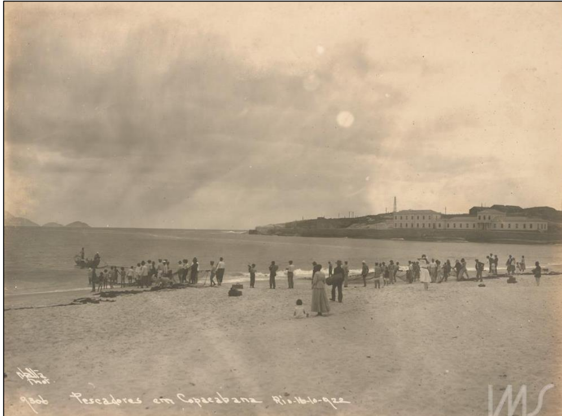
Figura 43 - Augusto Malta. Pescadores na praia de Copacabana, Rio de Janeiro, RJ, 1922
