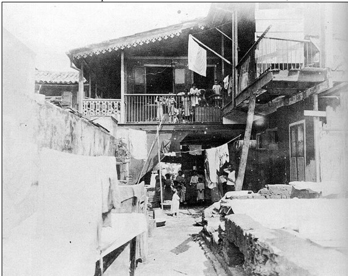
Figura 55 - Augusto Malta. Barracão de madeira (“cortiço”) componente da estalagem existente nos fundos dos prédios n. 12 a 44 da rua da Sé. Rio de Janeiro, 1906
