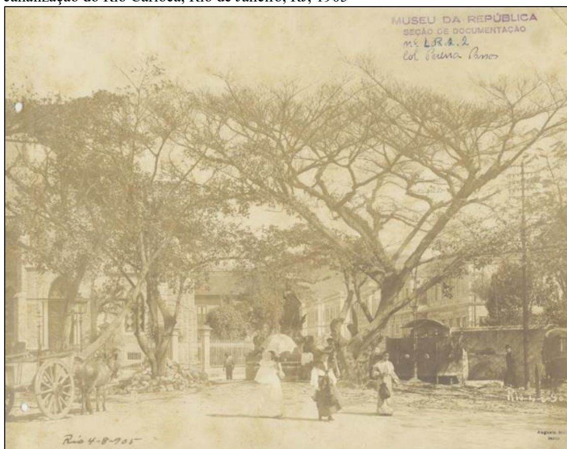
Figura 40 - Augusto Malta. Rua Conde de Baependi: vistas parciais durante as obras de canalização do Rio Carioca, Rio de Janeiro, RJ, 1905
