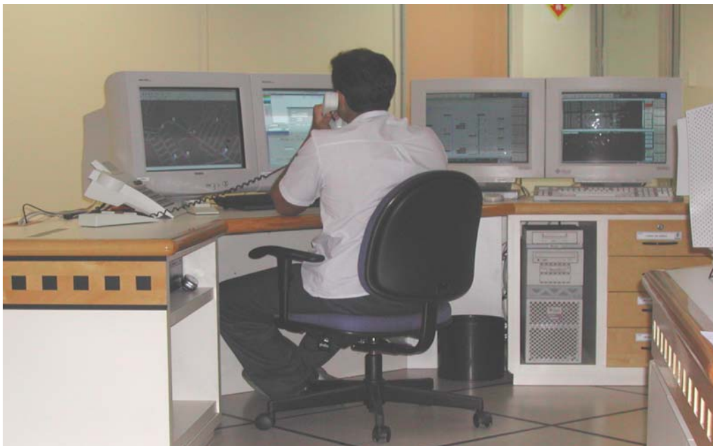
Ilustração 12 Estação de trabalho do atendente do Centro operativo de Carapina
