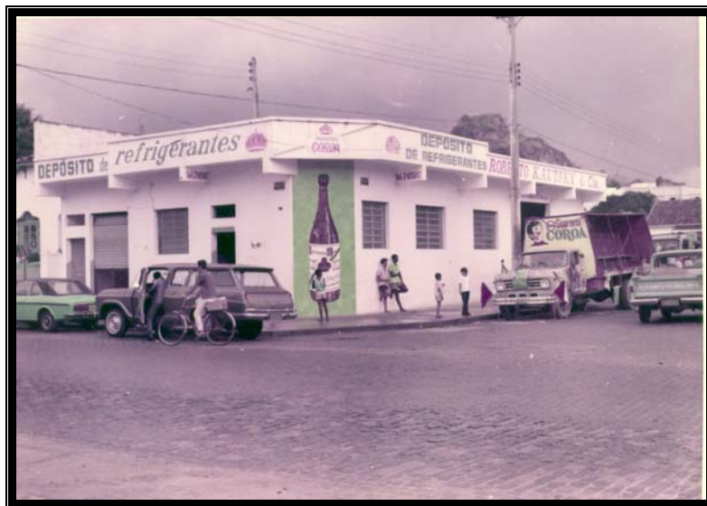
FOTO 25 – DEPÓSITO DA FÁBRICA DE REFRIGERANTES COROA EM VITÓRIA Fonte: Documentos da empresa.
