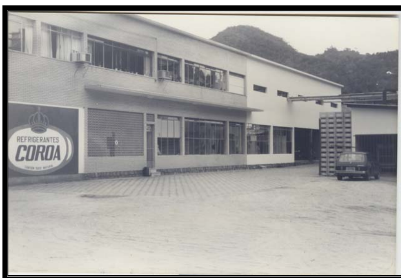
FOTO 24 – FÁBRICA REFRIGERANTES COROA APÓS AMPLIAÇÃO Fonte: Documentos da empresa.
