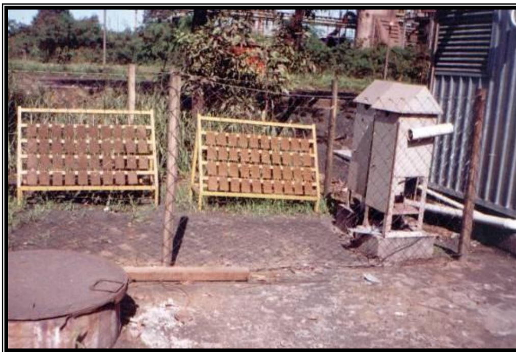
Figura 2.4 – Estação de exposição atmosférica na Usina 1.
