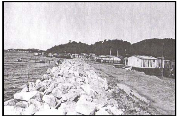
Foto 2 — Pedras usadas para a contenção da maré Fonte: Gurgel e Pessali (2004, p. 131)
