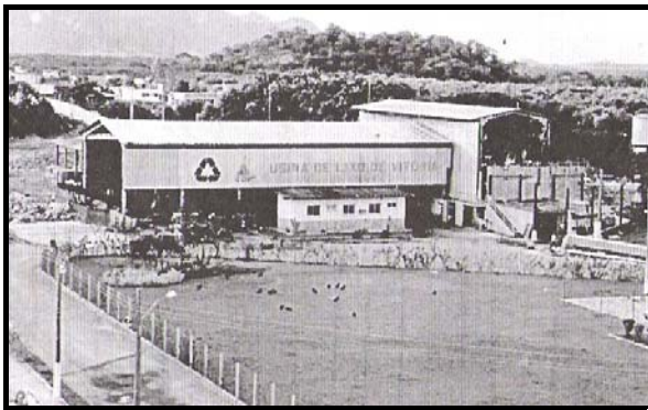
Foto 7 — Usina de Lixo de Vitória Fonte: Gurgel e Pessali (2004, p. 133)
